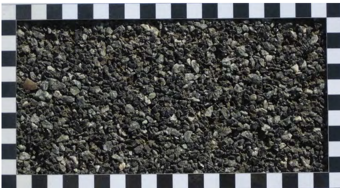
Slika 22. Fotografija 10 mjeseci stare porozno-elastične kolničke konstrukcije 18
