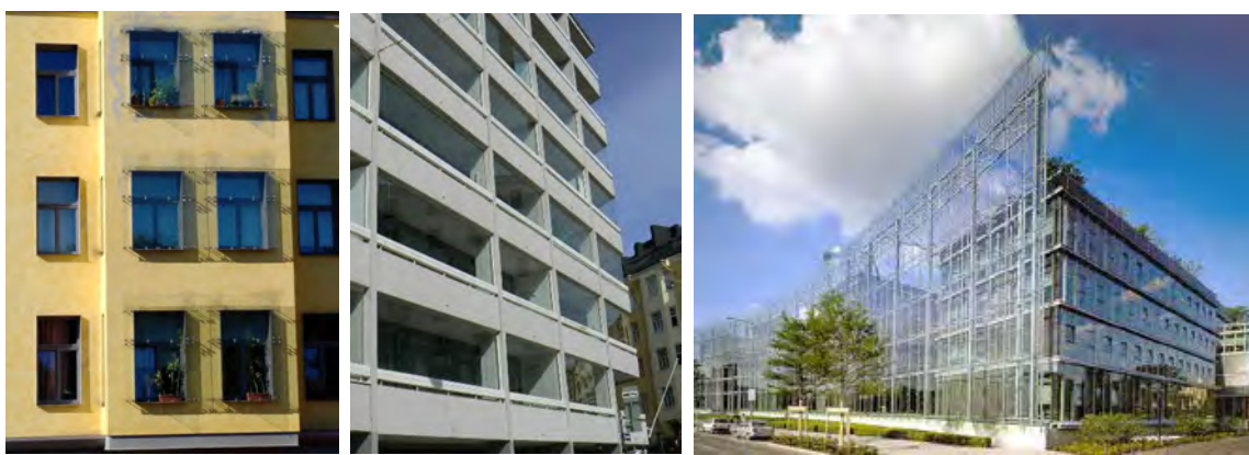
Slika 29. Prikaz ostakljenih zidova za zaštitu od buke
