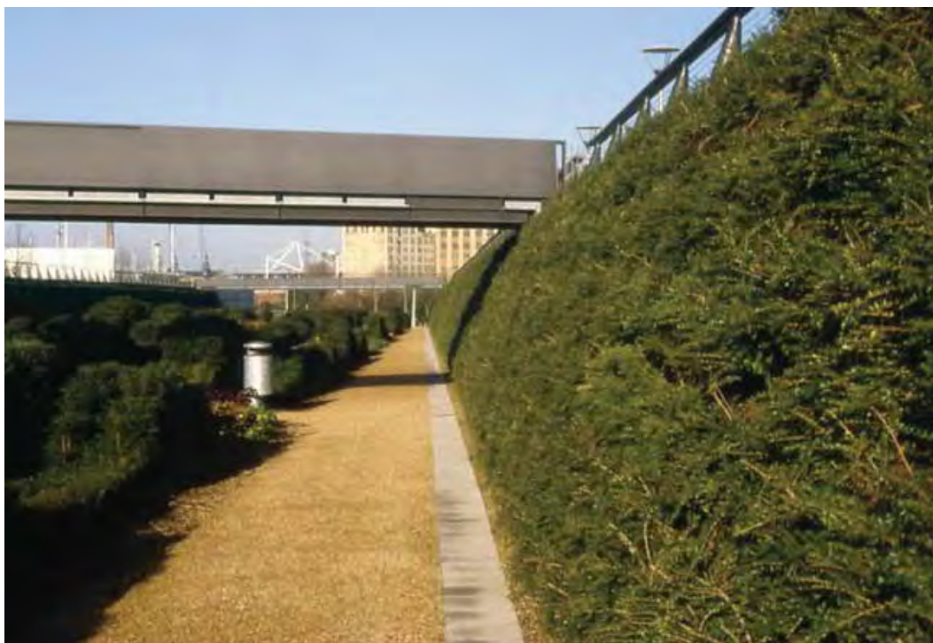
Slika 32. Prikaz izvedbe „ozelenjenog“ zida za zaštitu od buke
