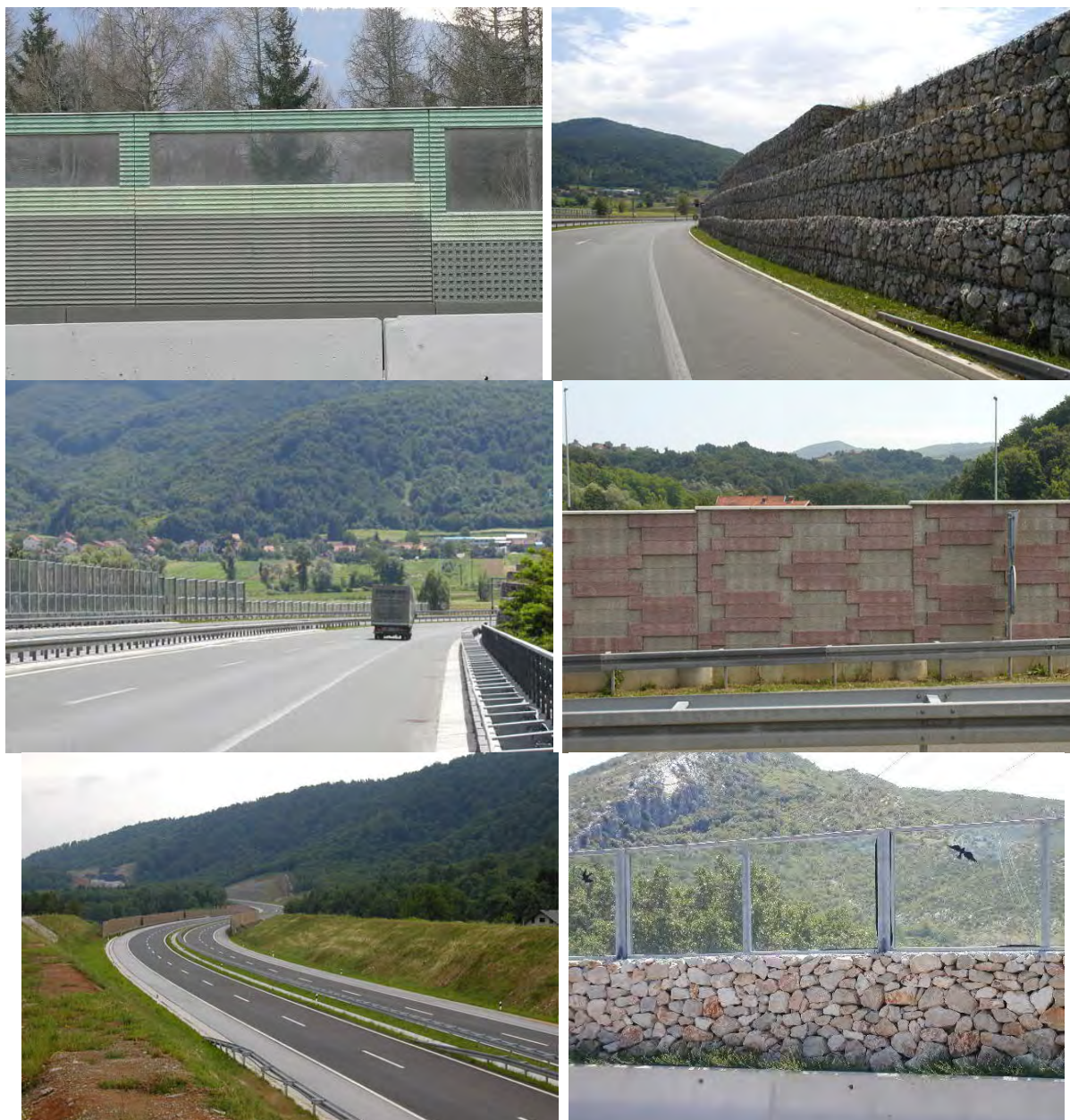
Slika 25. Prikazi izvedbe zidova za zaštitu od buke od raznih materijala
