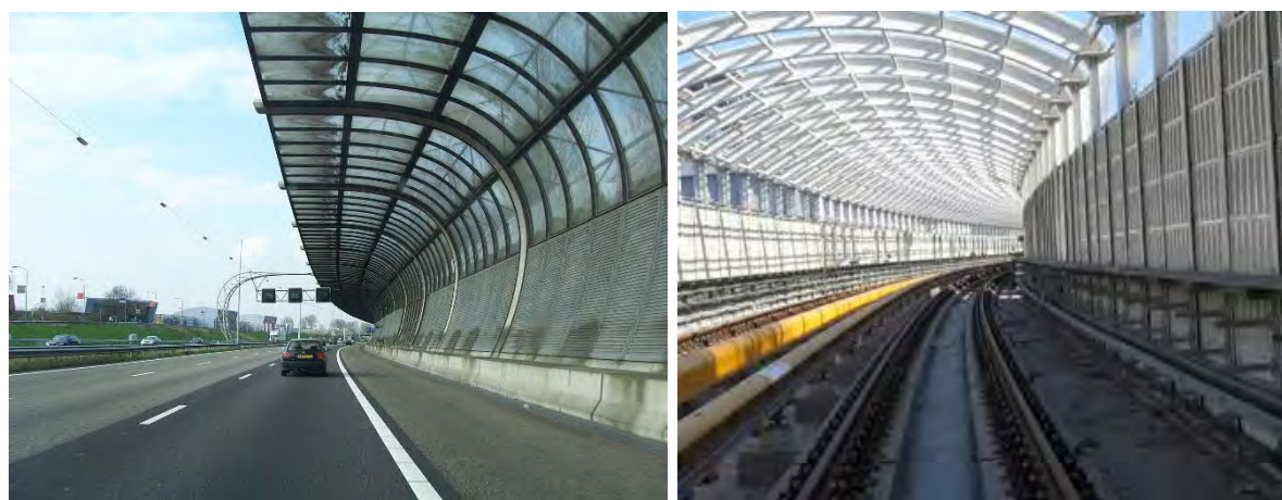
Slika 28. Prikaz složenih (polu)tunelskih konstrukcija zaštite od buke
