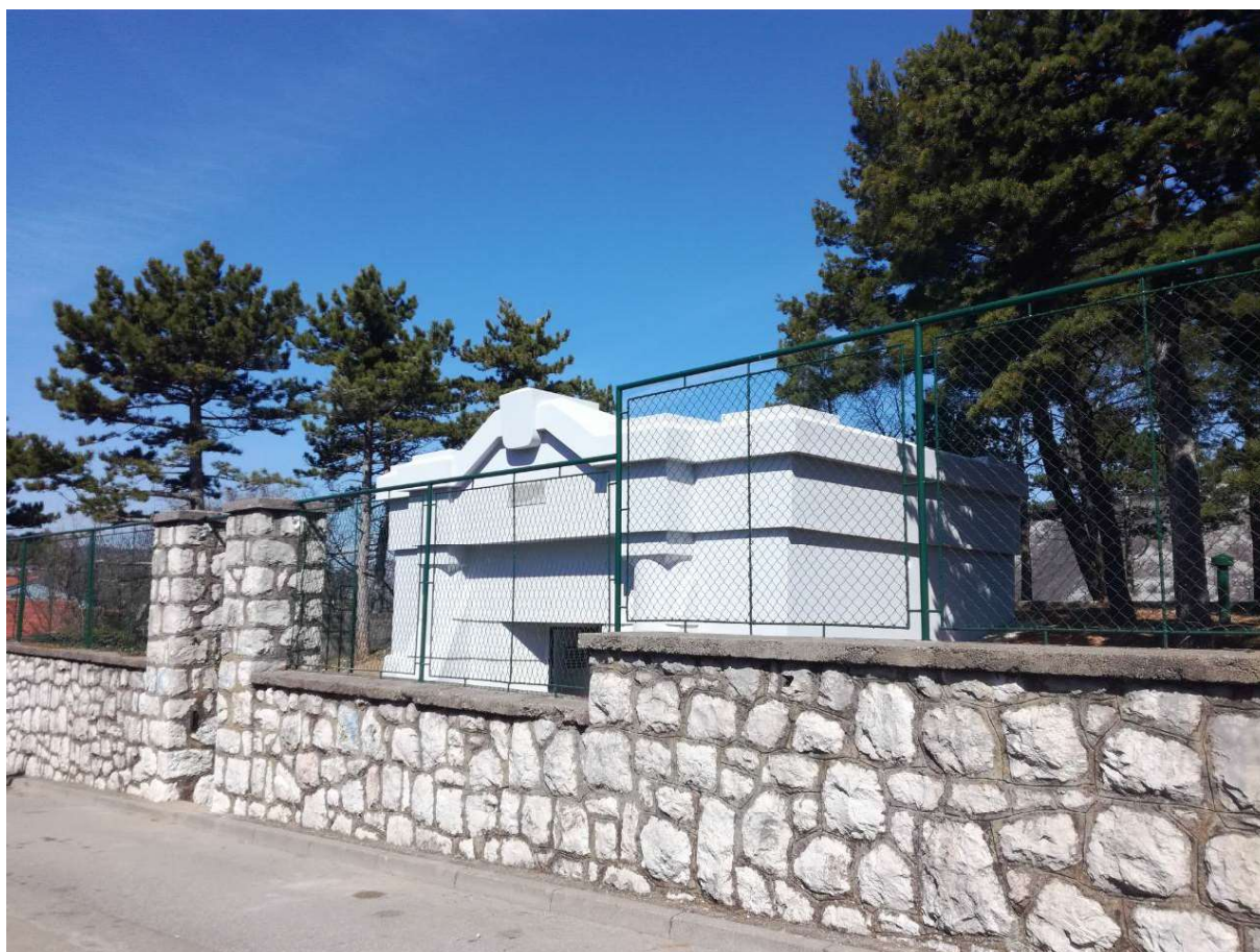
Slika 1: Obnovljena povijesna vodosprema Podvežica
