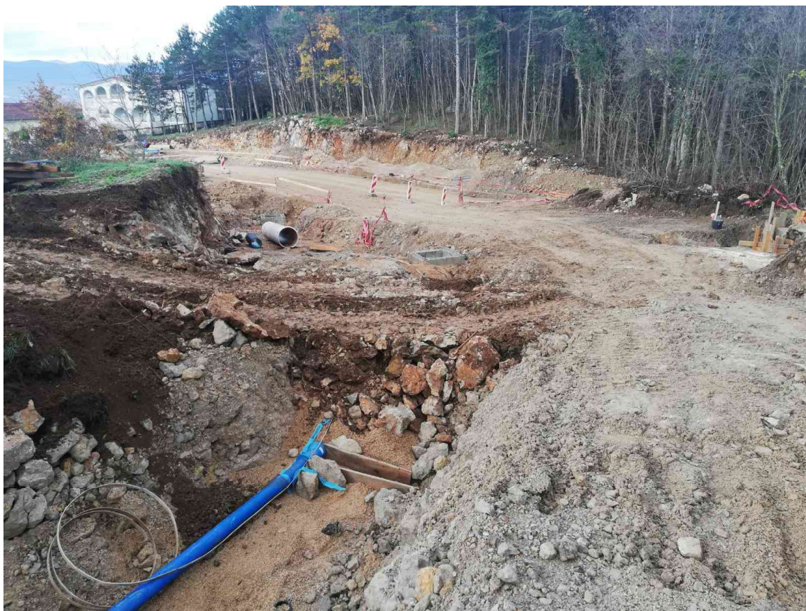
Slika 3: Radovi na komunalnoj infrastrukturi - rekonstrukcija dijela županijske ceste Ž 5055, I.faza - dionica Mladenići-Ronjgi (dio EU projekta aglomeracije Rijeka)
