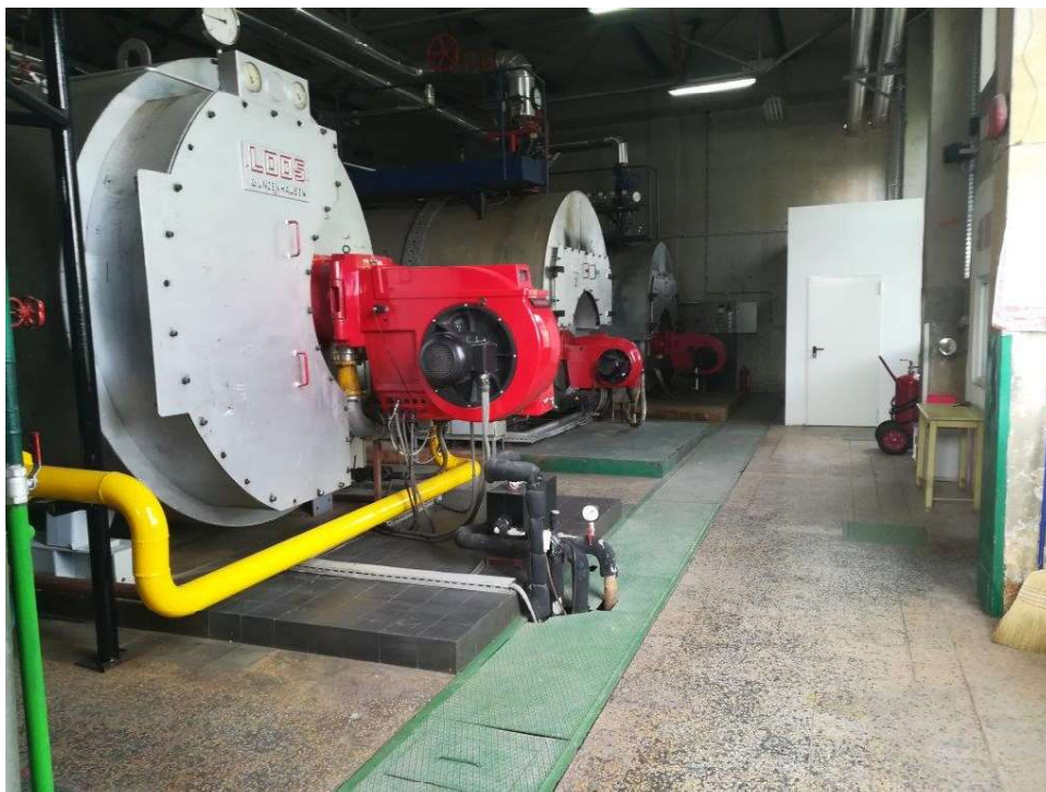
Slika 7: Izvedeni radovi – Plinifikacija glavnog kotla na toplani Vojak u 2019
