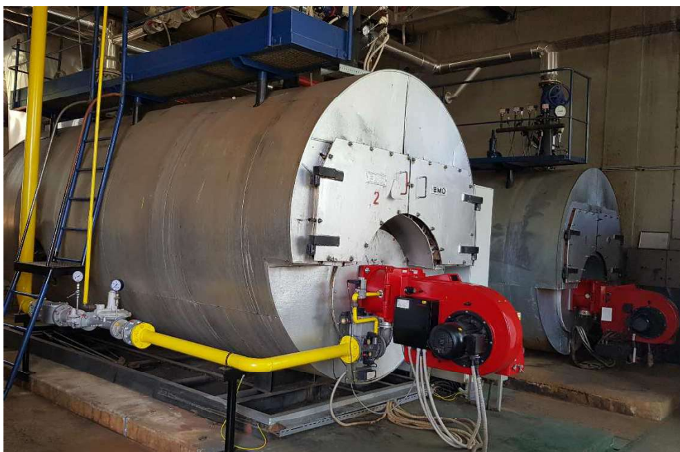
Slika 8: Izvedeni radovi – Plinifikacija drugog kotla na toplani Vojak u 2020
