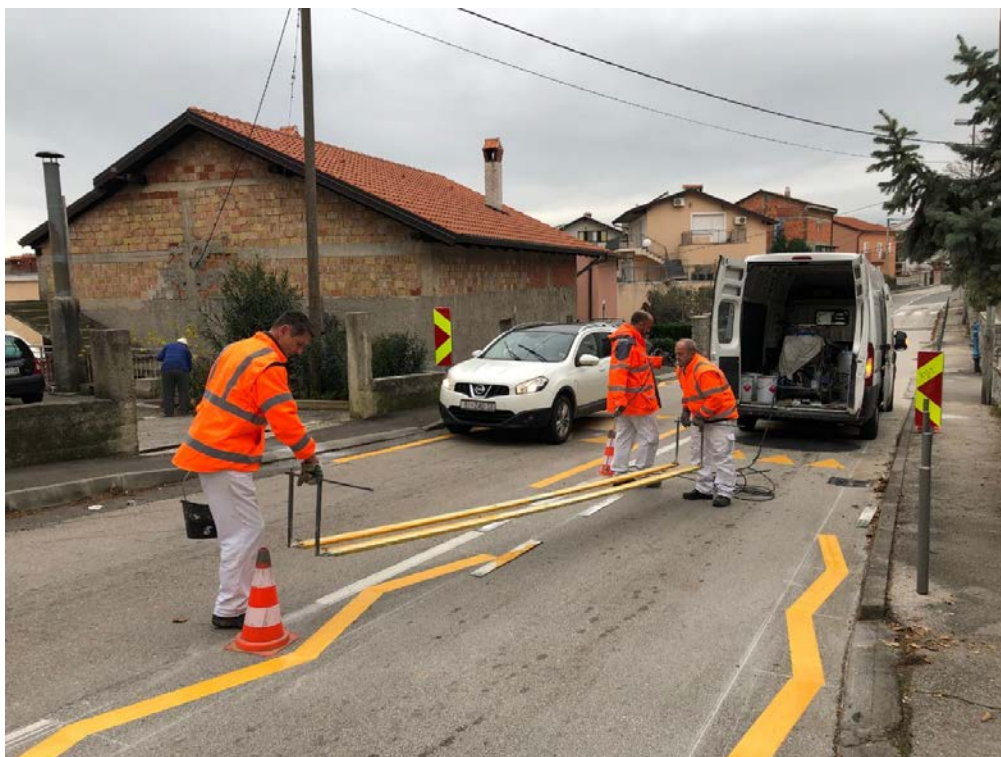
Radovi na označavanju horizontalne prometne signalizacije na lokacijama na kojima su postavljene novi usporivači prometa tipa „jastuk“.
