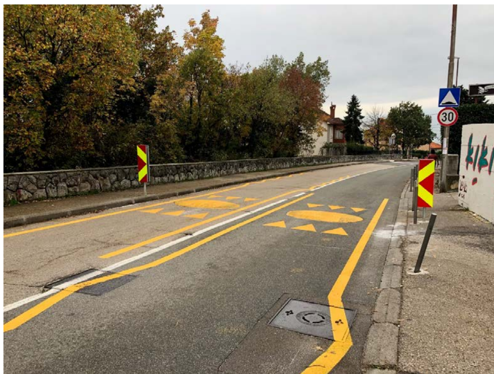
Usporivači prometa tipa "jastuk" izvedeni su u obliku umjetnih asfaltnih izbočina na kolniku, čiji je cilj prinudno usporavanje prometa vozila. Pri tome vozila veće širine, kao što su kombi vozila i autobusi, mogu bez neugodnih vibracija proći samu izbočinu, dok osobna vozila, čija je širina manja, moraju nagaziti na izbočinu i radi toga smanjiti brzinu.
