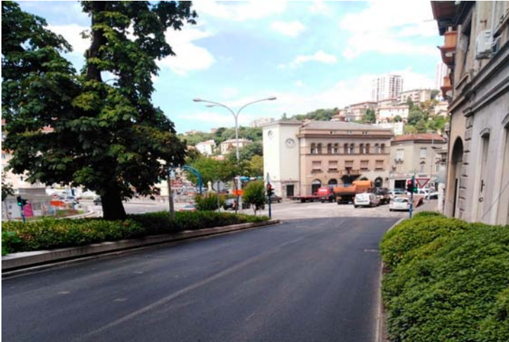
Sanacija kolnika u Križanićevoj ulici, površine zahvata 1.479,50 m 2
