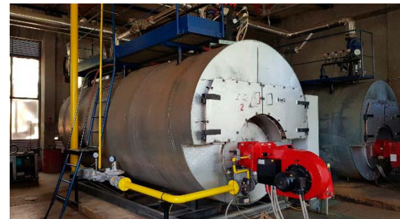
Slika 7. Izvedeni radovi – plinifikacija srednjeg kotla na toplani Vojak
