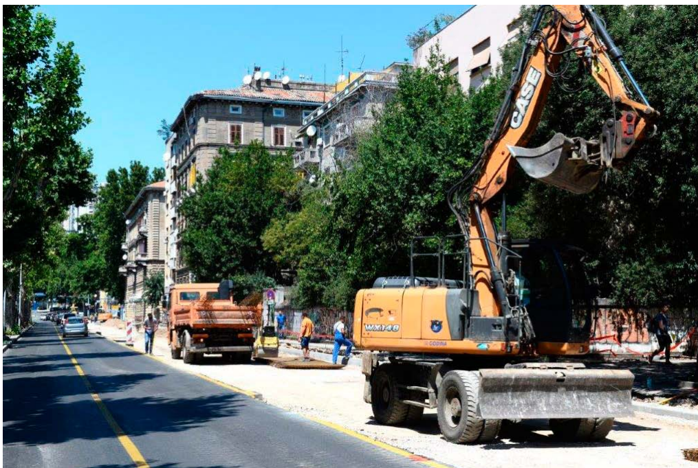
Radovi na rekonstrukciji i dogradnji sustava odvodnje otpadnih voda i poboljšanja postojećeg sustava odvodnje na lokaciji križanje Mlaka – I. faza – Krešimirova (dio EU projekta Aglomeracije Rijeka)
