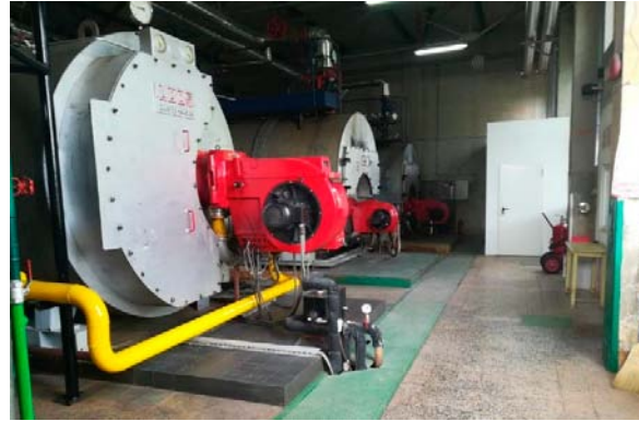
Slika 6. Izvedeni radovi – plinifikacija glavnog kotla na toplani Vojak
