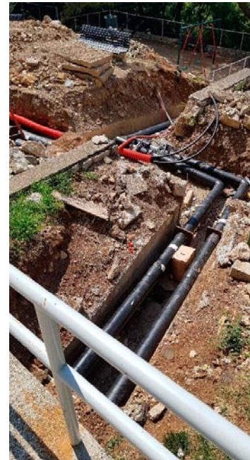
Slika 5. Izvedeni radovi – sustav Škurinje
