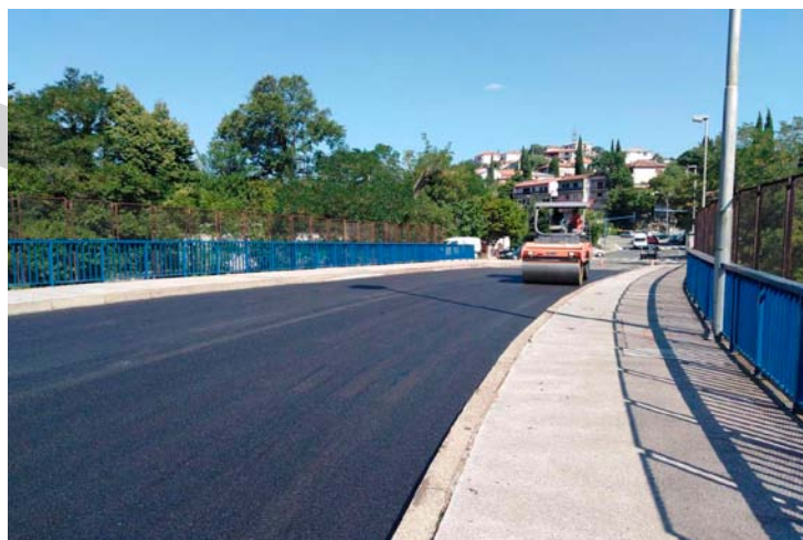
Sanacija kolnika nadvožnjaka Orehovica, površine zahvata 392.70 m 2
