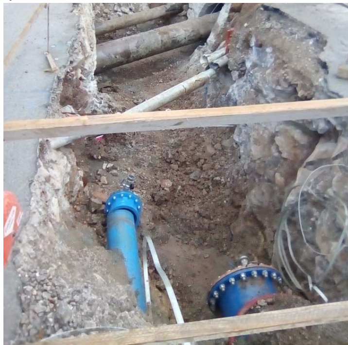
Slika 2: Zamjena cjevovoda u ŽC 5021 – opskrbeni i transportni cjevovod
