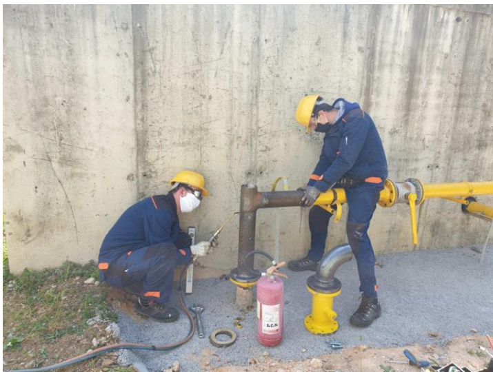
Slika 11: Izrada plinske instalacije za punionicu na lokaciji Milutina Barača
