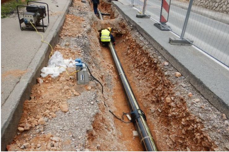
Slika 9: Izgradnja pliovoda na području grada Bakra – industrijska zona Kukuljanovo
