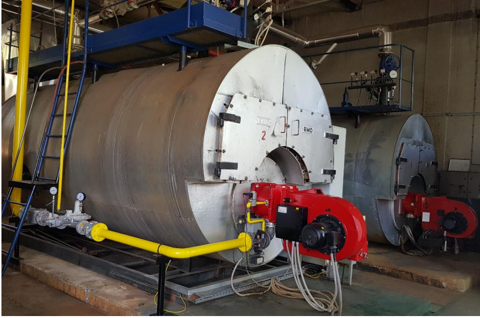
Slika 7: Izvedeni radovi – Plinifikacija drugog kotla na toplani Vojak u 2020
