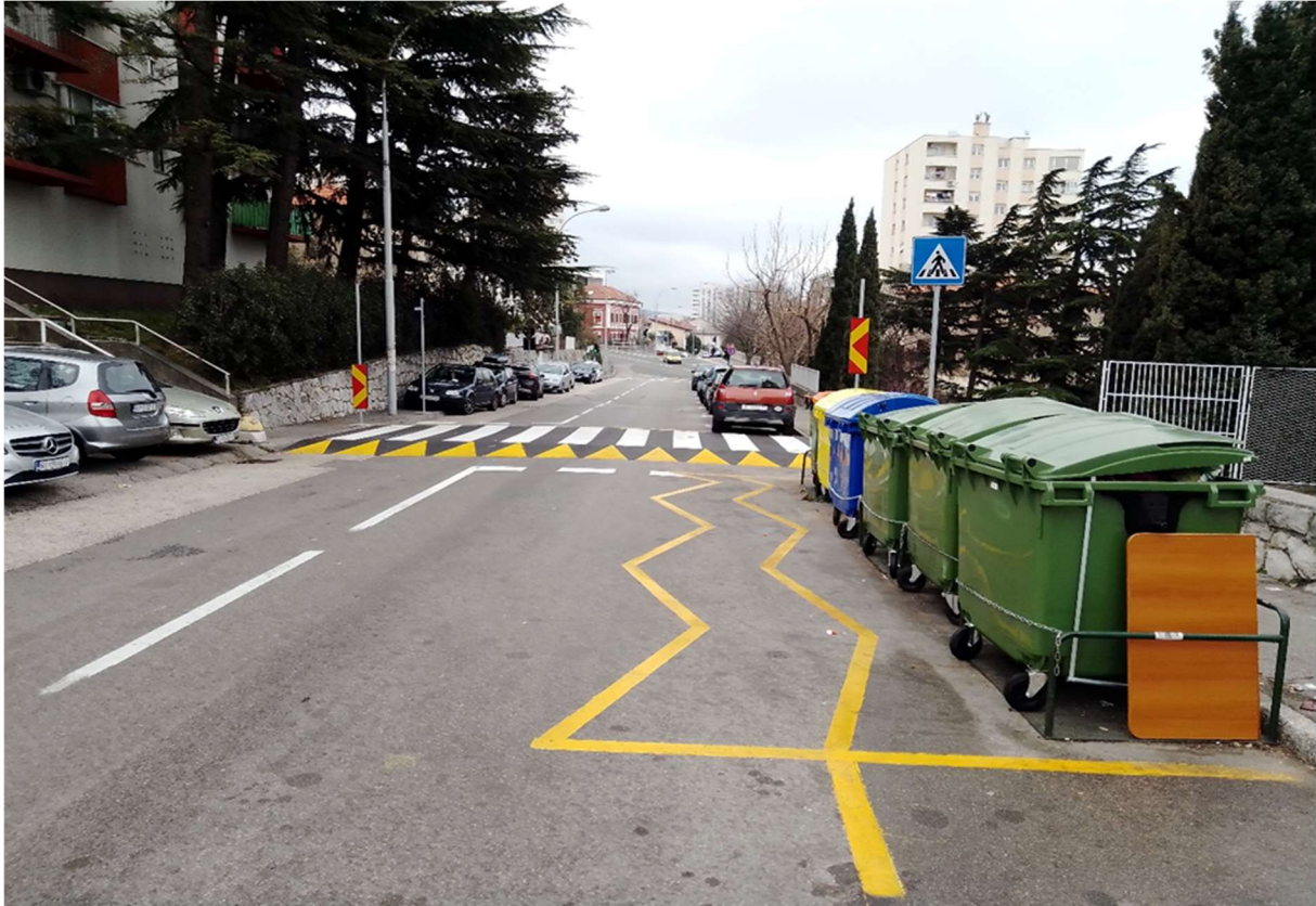
Pogled sa sjevera na uzdignutu plohu na pješačkom prijelazu u Ulici Krimeja
