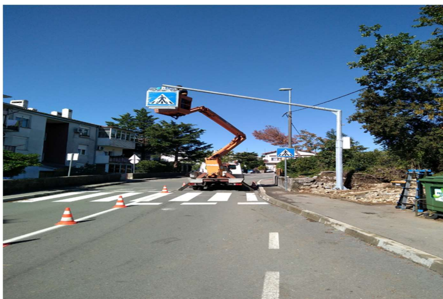
Pogled s juga na Ulicu Drenovski put i postavljenu prometnu signalizaciju.
