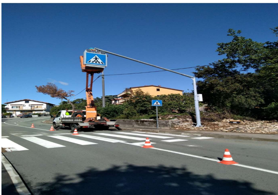
Pogled s juga na Ulicu Drenovski put i postavljenu prometnu signalizaciju
