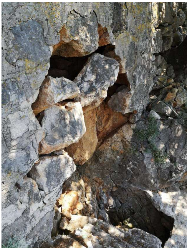
Oštećenja potpornog kamenog zida na dijelu zida (slika 4 / slika 5)
