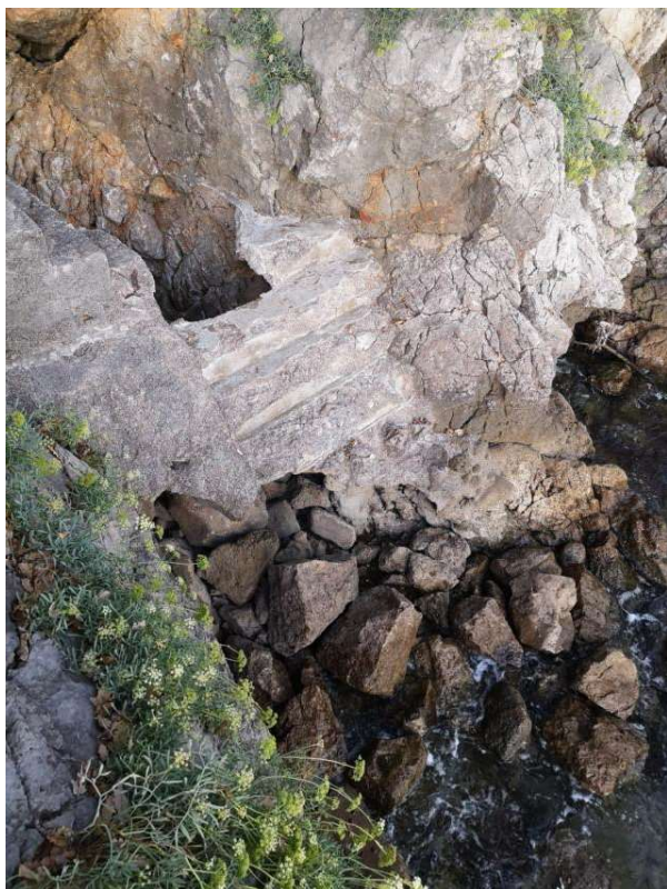
Stepenice / Oštećenje podesta stepenica / krak stepenica prema moru (slika 9 / slika 10 / slika 11)
