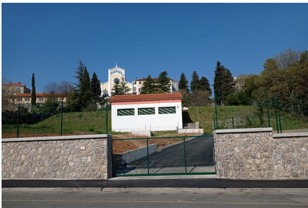
Slika 1: CS Plase – sanacija ogradnog zida
