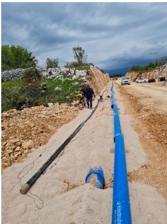
Slika 8: Izgradnja plinovoda na području grada Bakra – industrijska zona Kukuljanovo
