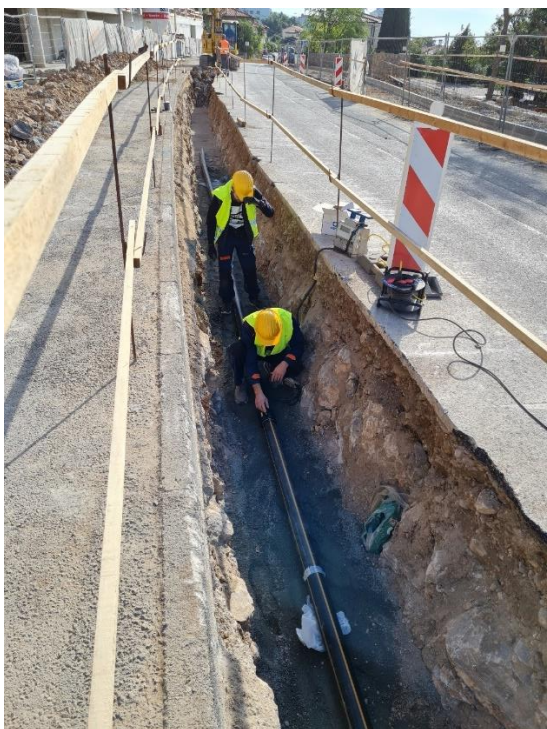
Slika 9: Izgradnja plinovoda u Labinskoj ulici
