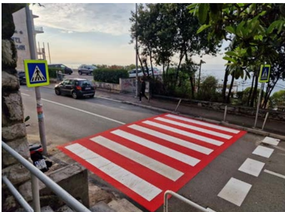
Pješački prijelaz izveden u crvenoj termoplastici – Šetalište XIII.divizije
