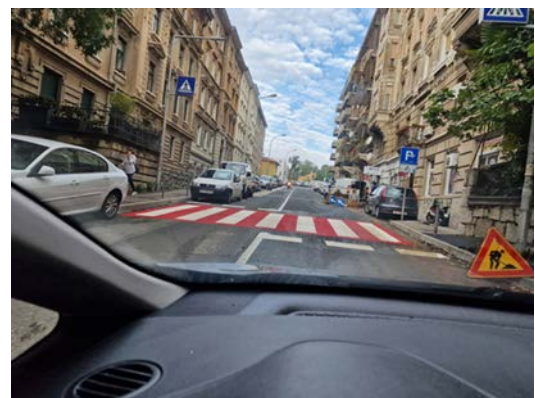
Pješački prijelaz izveden u crvenoj termoplastici – Laginjina ulica
