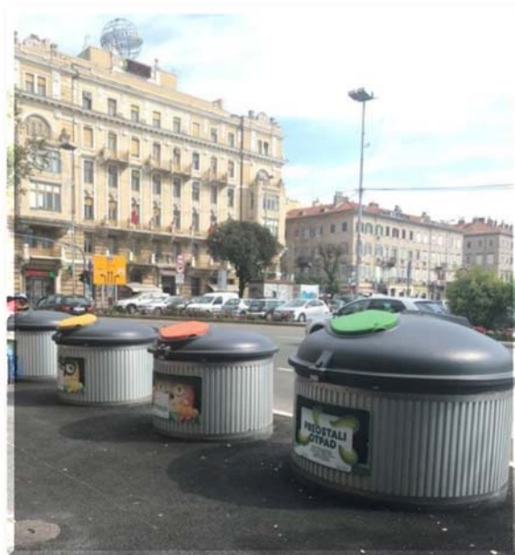
Slika 3. Poluukopani spremnici na lokaciji Riva 4
