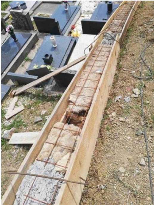
Sanacija zapadnog ogradnog zida, groblje Draga
