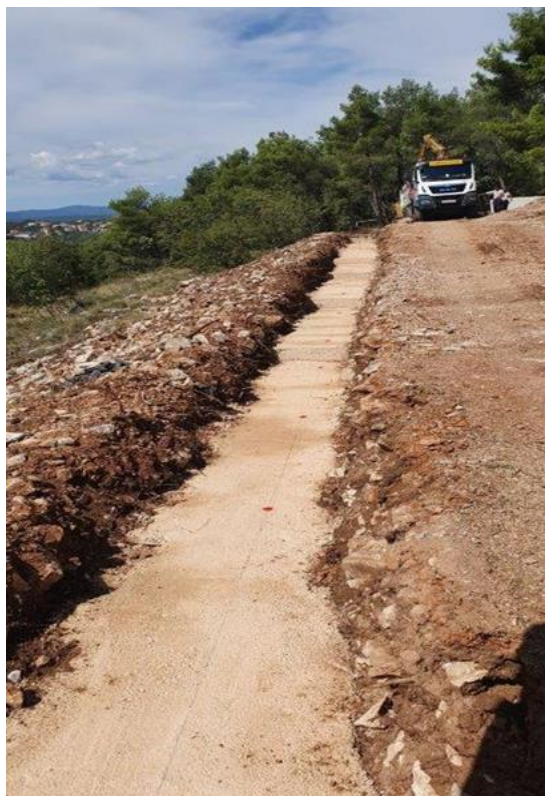
Nastavak ograđivanja betonskim zidom CGG Drenova
