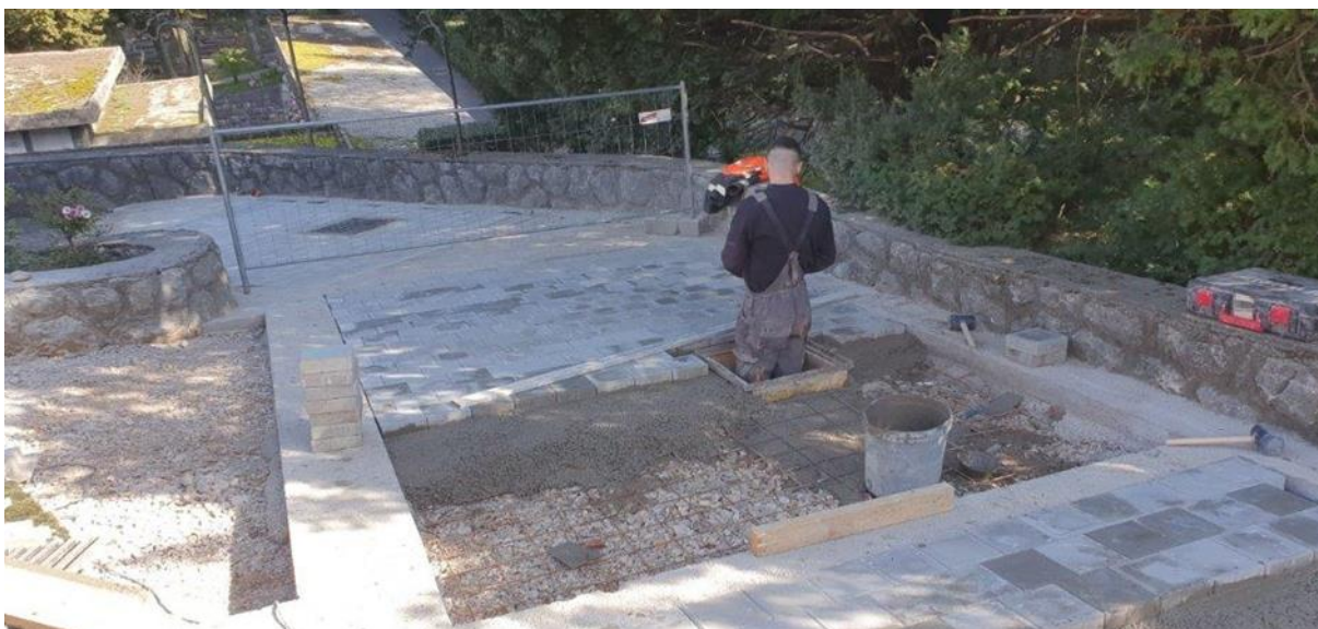
Groblje Kozala, polje O, sanacija vodovodnog kanala i opločenje
