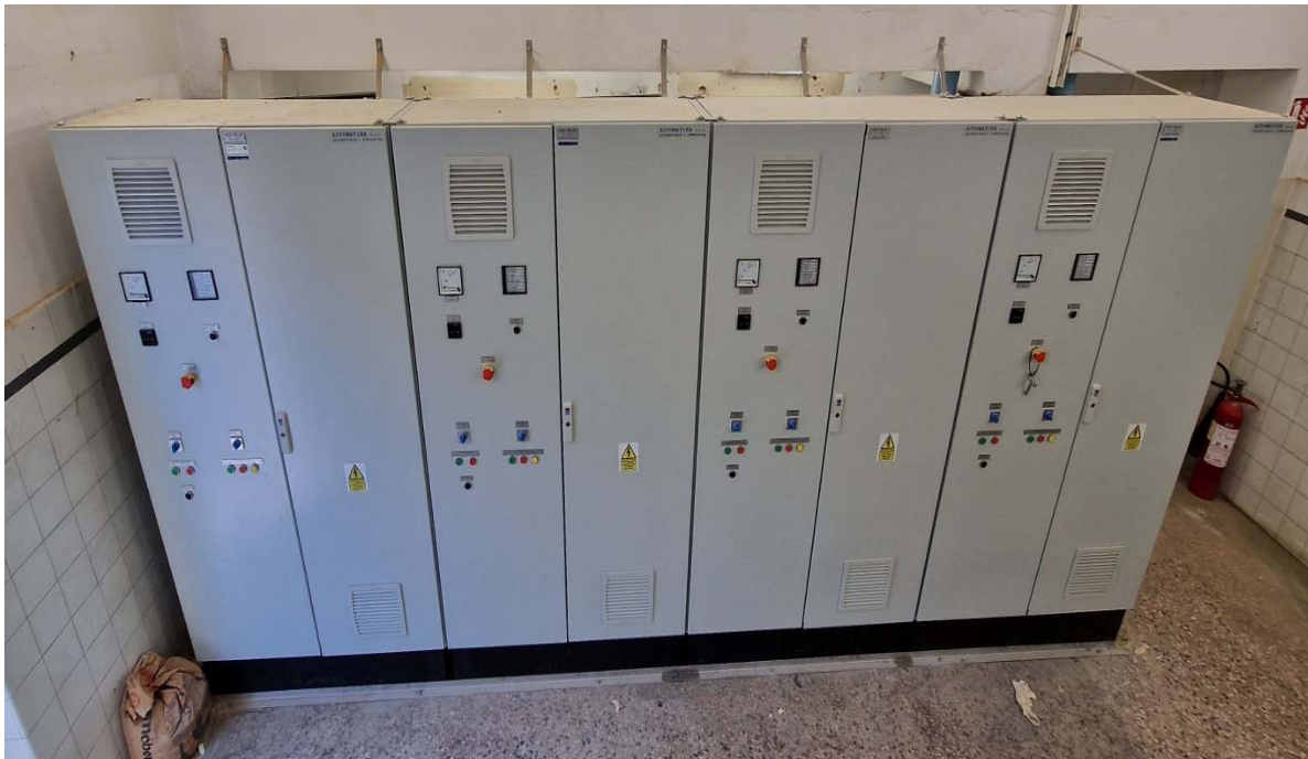
Slika 2: CS/TS Plase (Rijeka) – zamjena niskonaponske opreme
