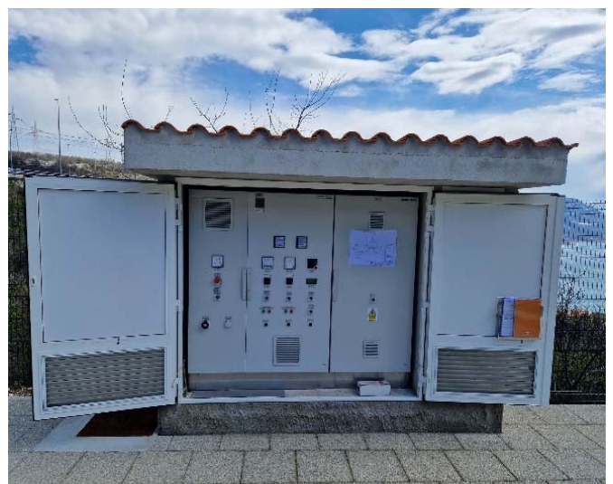
Slika 8: CS Sveti Kuzam – sanacija objekta
