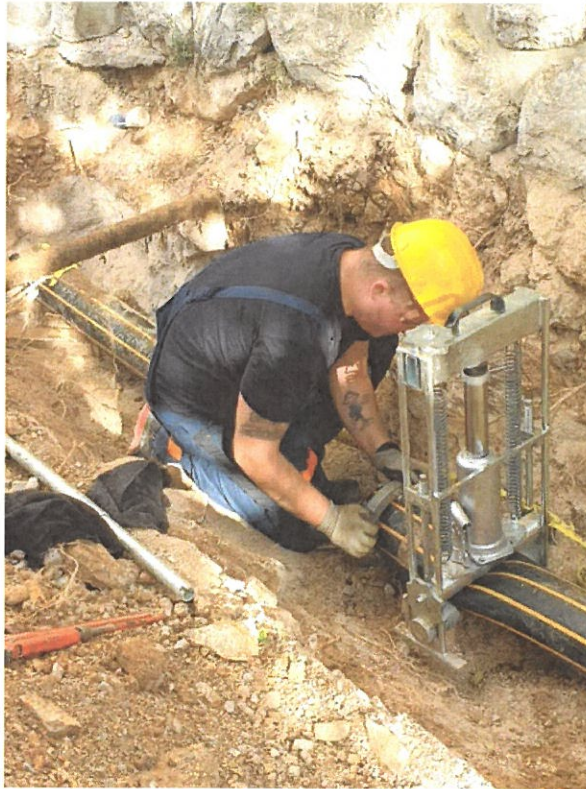
Slika 7: Izgradnja priključka za toplanu Zamet u Rijeci
