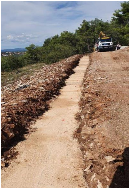
Nastavak ograđivanja betonskim zidom CGG Drenova
