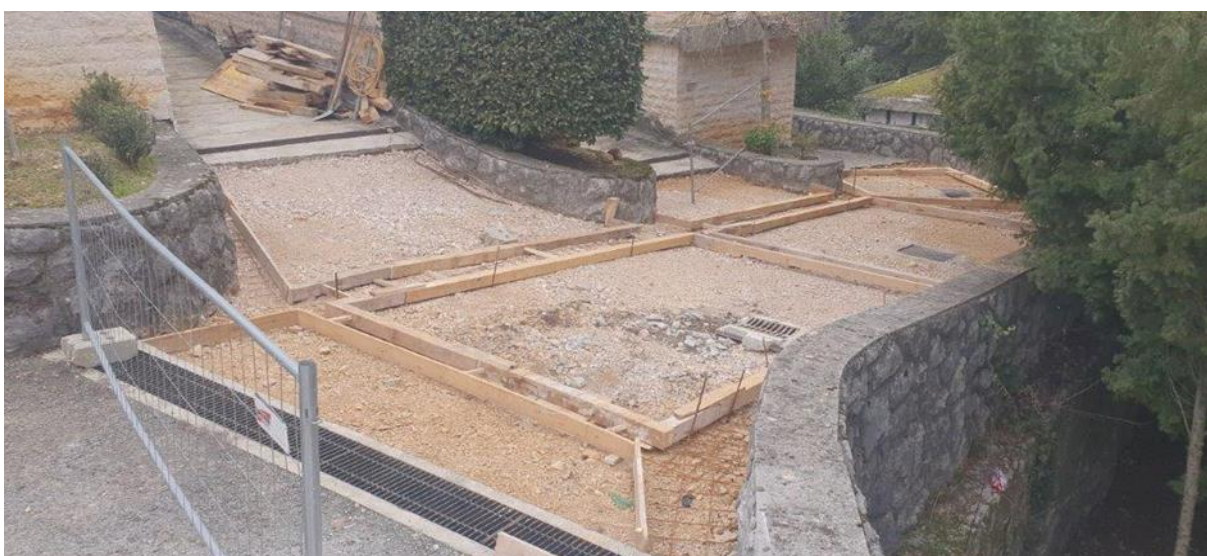
Groblje Kozala, polje O, sanacija vodovodnog kanala i opločenje
