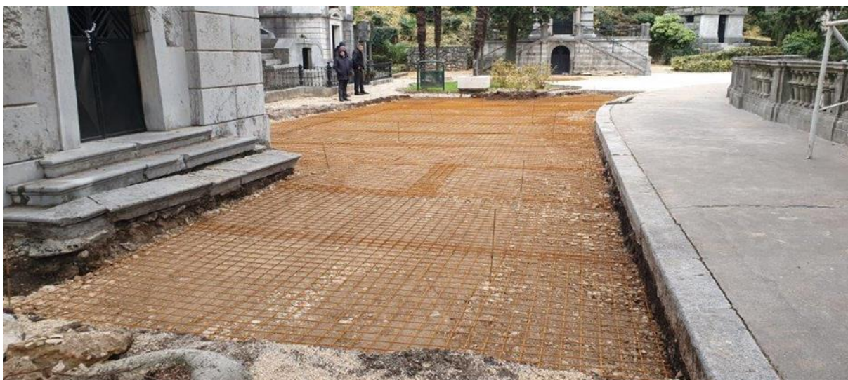
Groblje Kozala, polje E (potkova), sanacija vodovodnog kanala i opločenje
