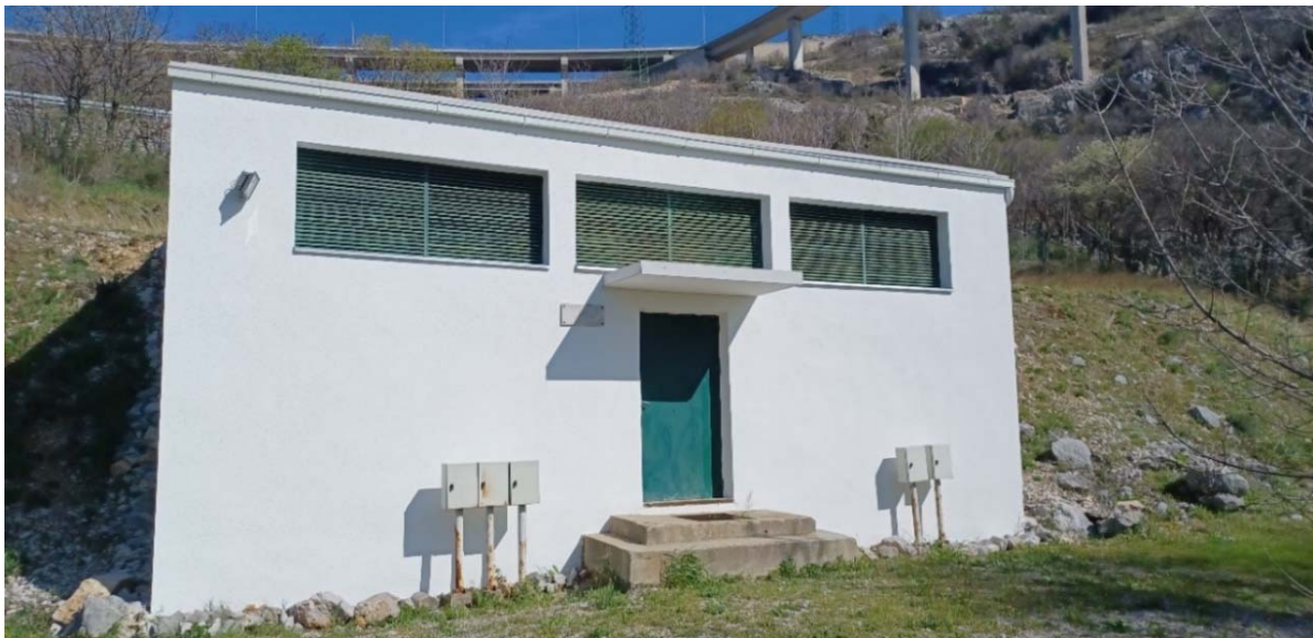
Slika 3: VS Bakar- sanacija vanjskih djelova objekta
