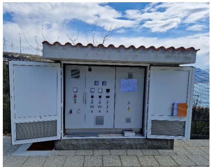
Slika 8: CS Sveti Kuzam – sanacija objekta
