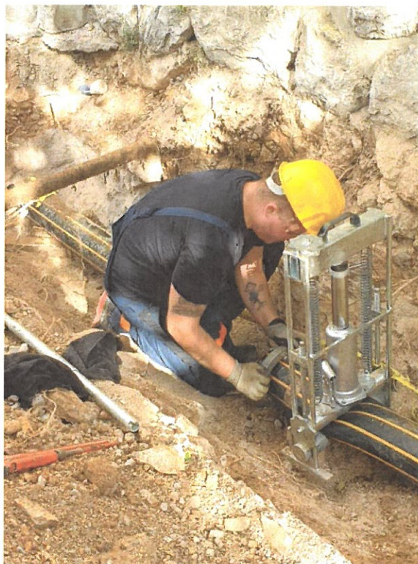
Slika 7: Izgradnja priključka za toplanu Zamet u Rijeci
