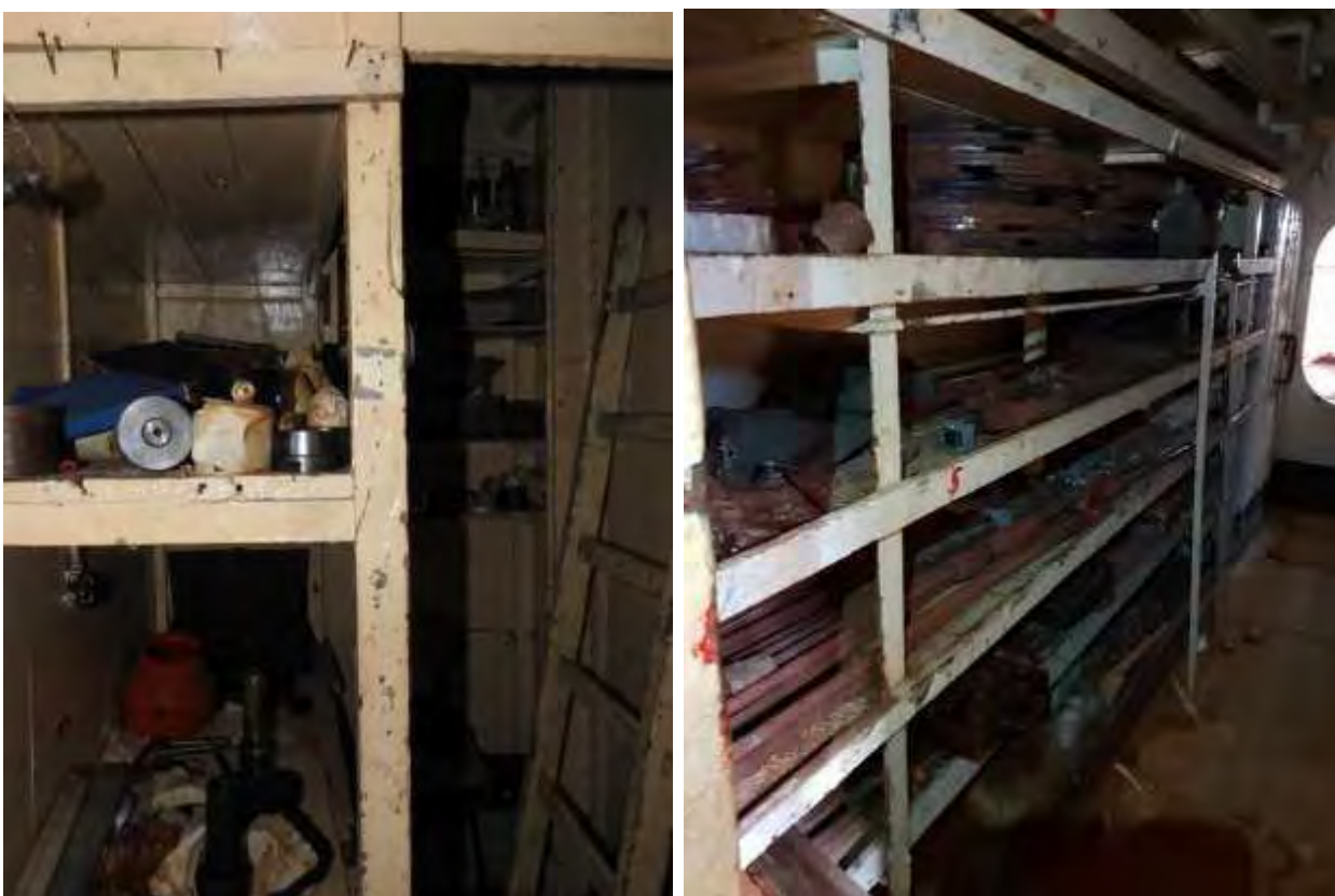
Fotografija postojećeg stanja 133 a i b
