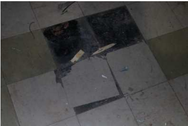
Fotografija postojećeg stanja 91
