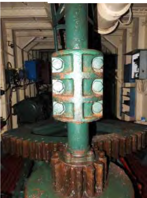
Fotografija postojećeg stanja 100 a i b
