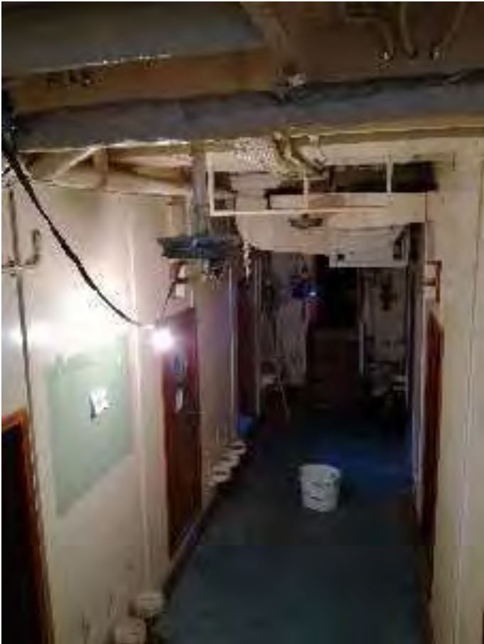
Fotografija postojećeg stanja 103
