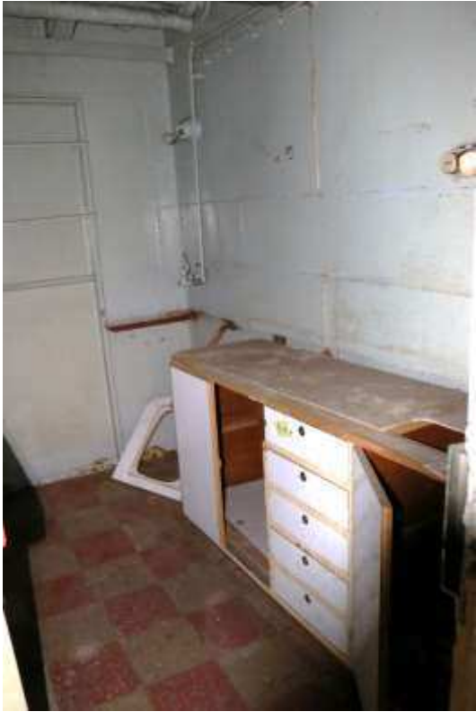
Fotografija postojećeg stanja 110 a i b
