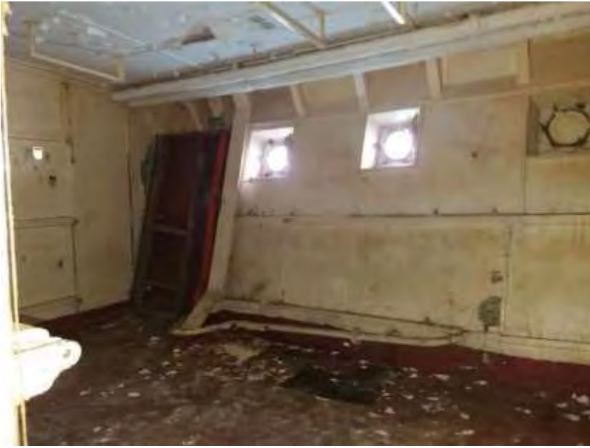
Fotografija postojećeg stanja 143
