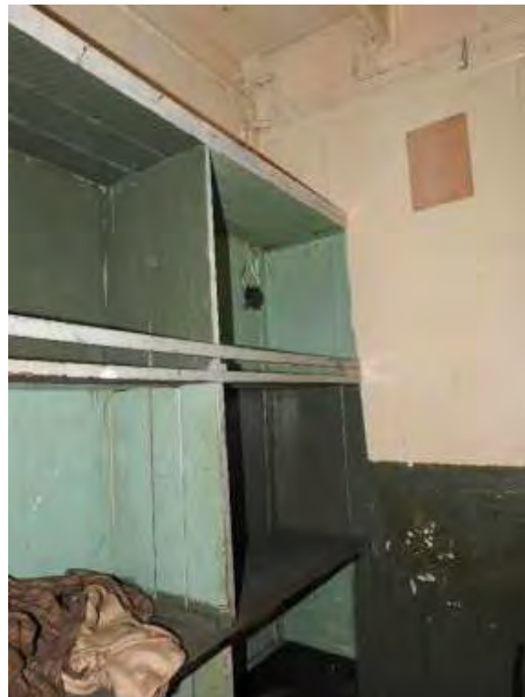
Fotografija postojeeeg stanja 160 a, b
