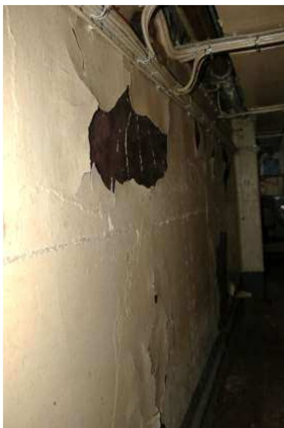
Fotografija postojećeg stanja 124
