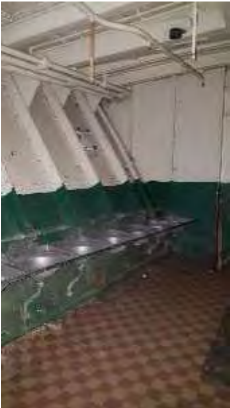
Fotografija postojećeg stanja 146
