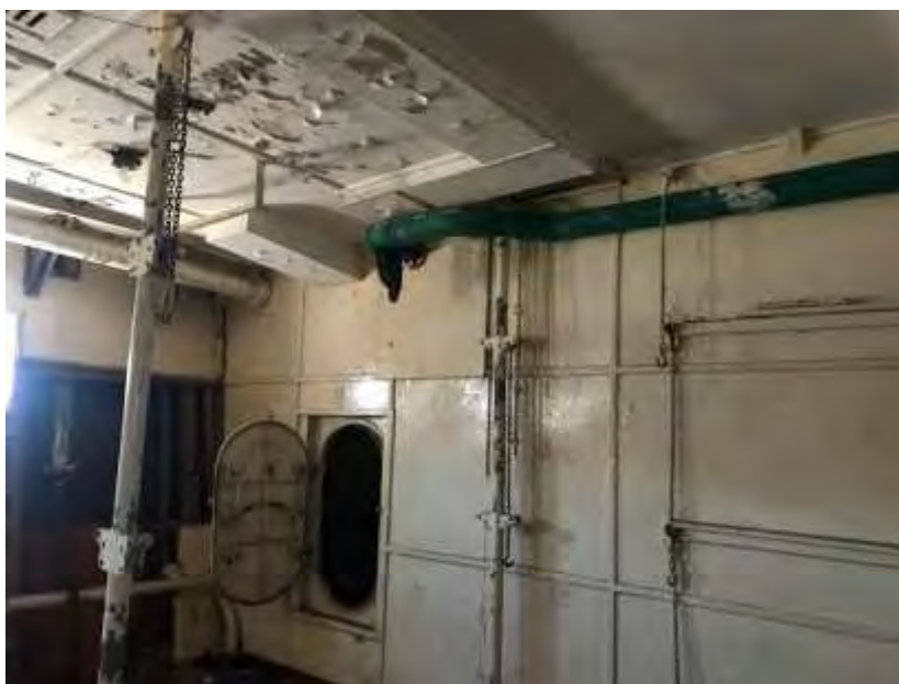
Fotografija postojećeg stanja 140
