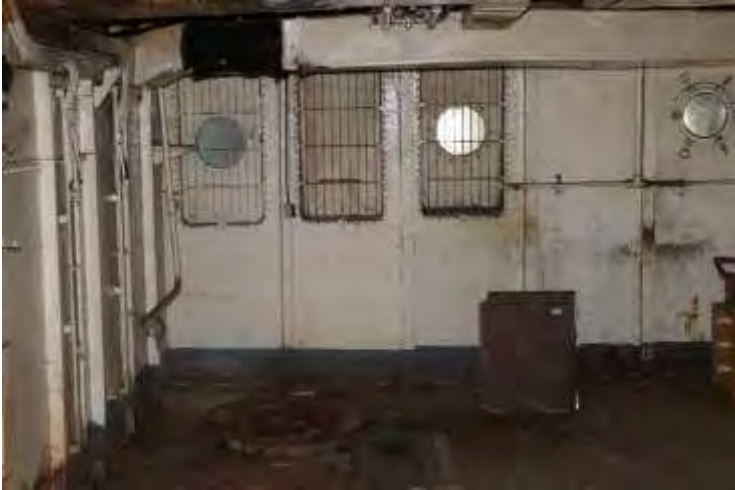
Fotografija postojećeg stanja 82
