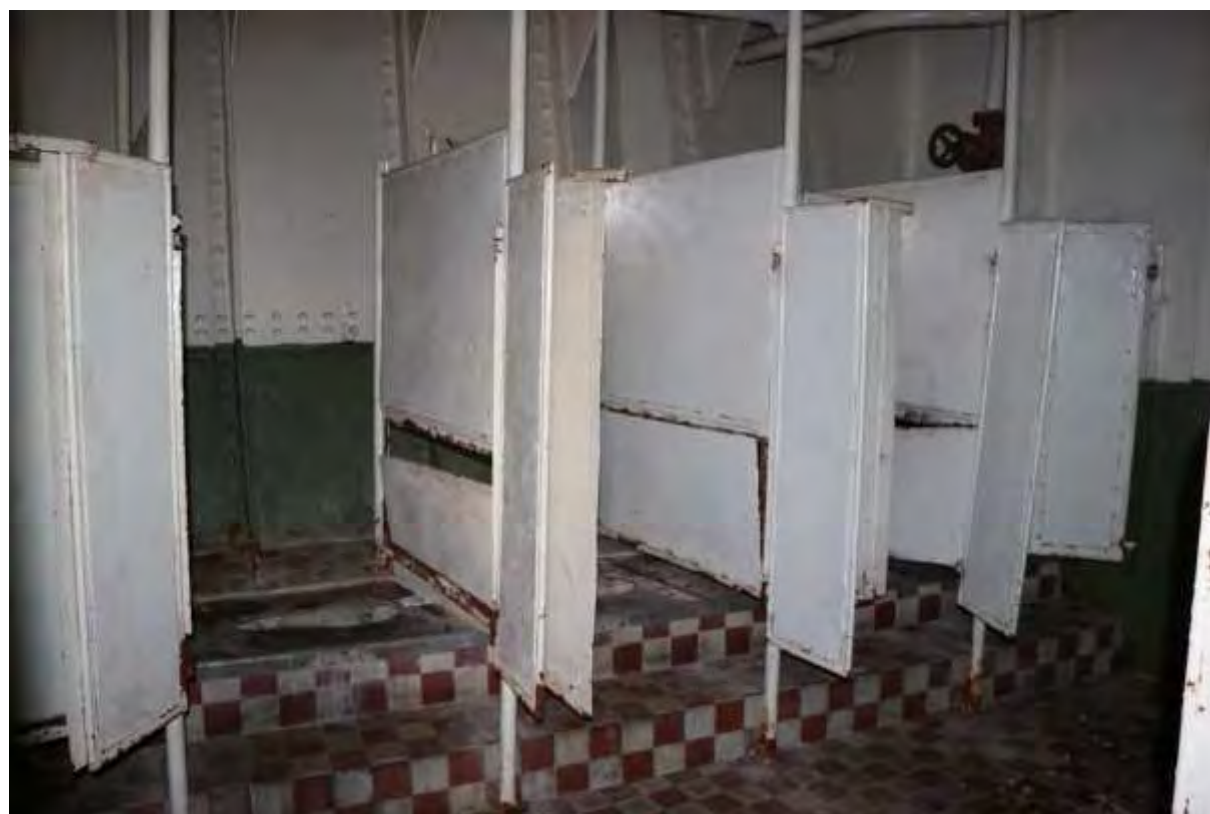
Fotografija postojećeg stanja 113
