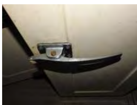
Fotografija postojećeg stanja 136 a i b
