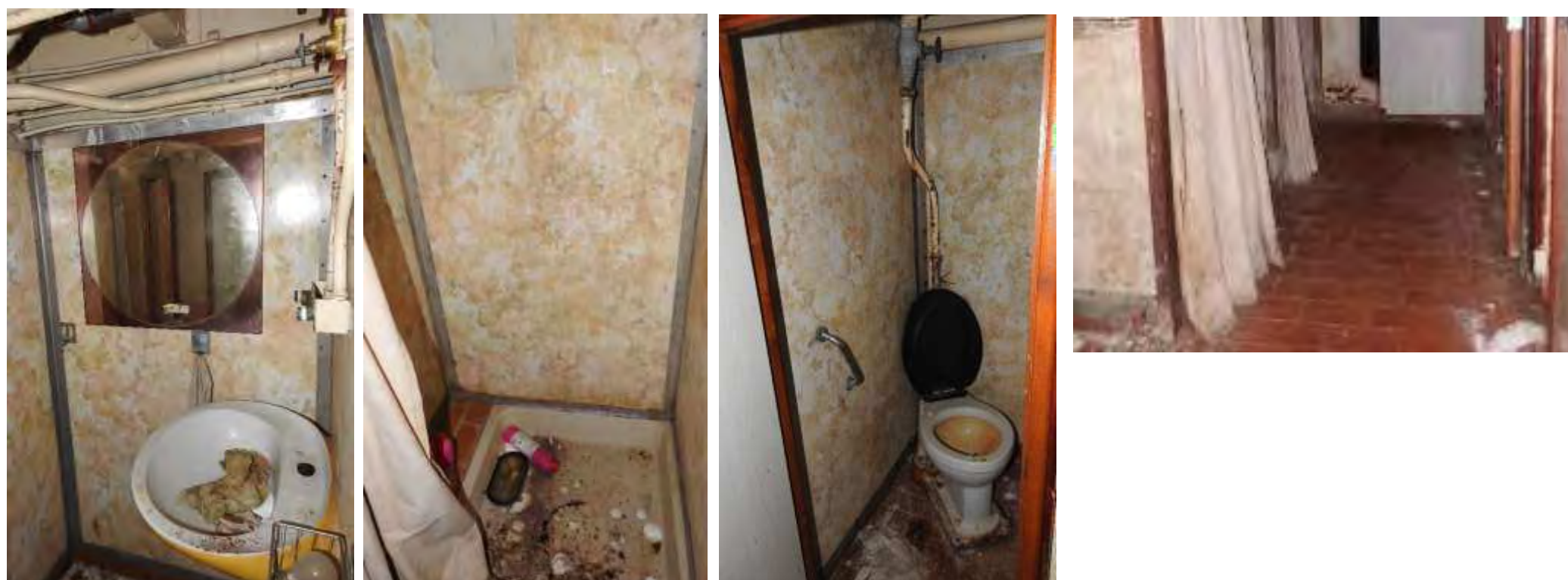
Fotografija postojećeg stanja 101 a, b, c i d
