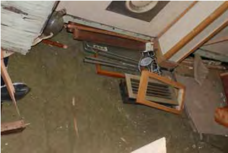
Fotografija postojećeg stanja 68
