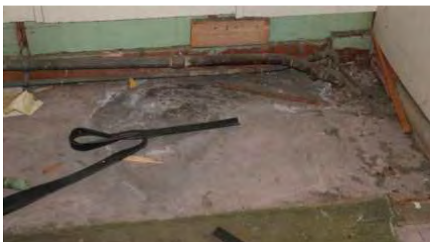
Fotografija postojećeg stanja 78
