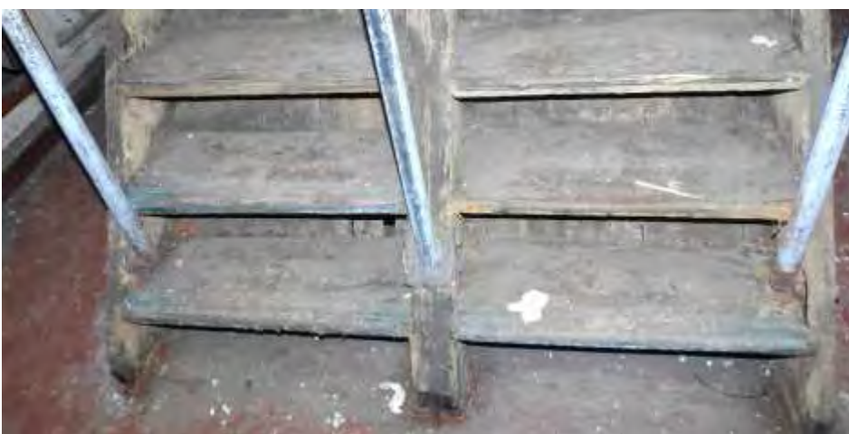
Fotografija postojećeg stanja 138 a i b
