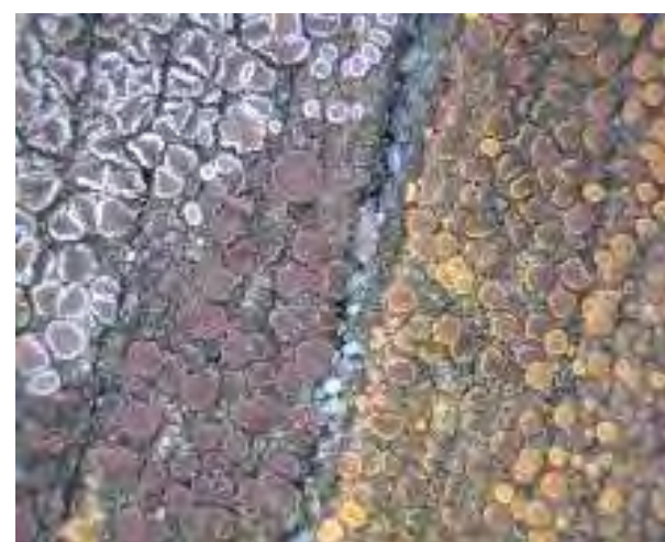
Slika 60, Biološki obraštaj na konstrukciji stubišta šetne palube, izvor: eLABORO d.o.o.
