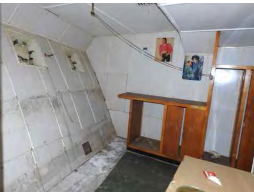
Fotografija postojećeg stanja 151
