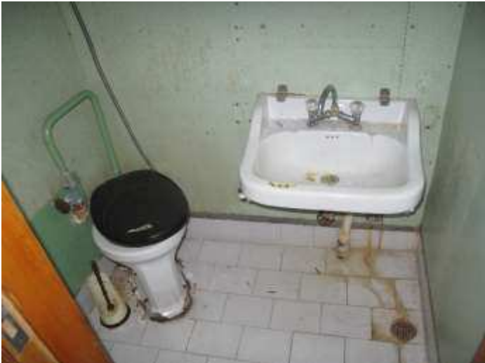
Fotografija postojećeg stanja 43
