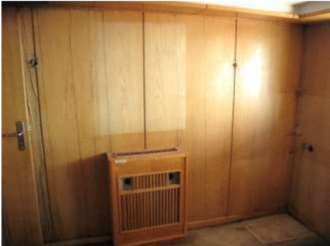
Fotografija postojećeg stanja 31
