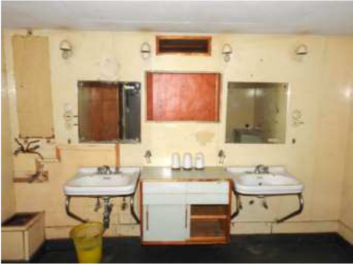
Fotografija postojećeg stanja 64
