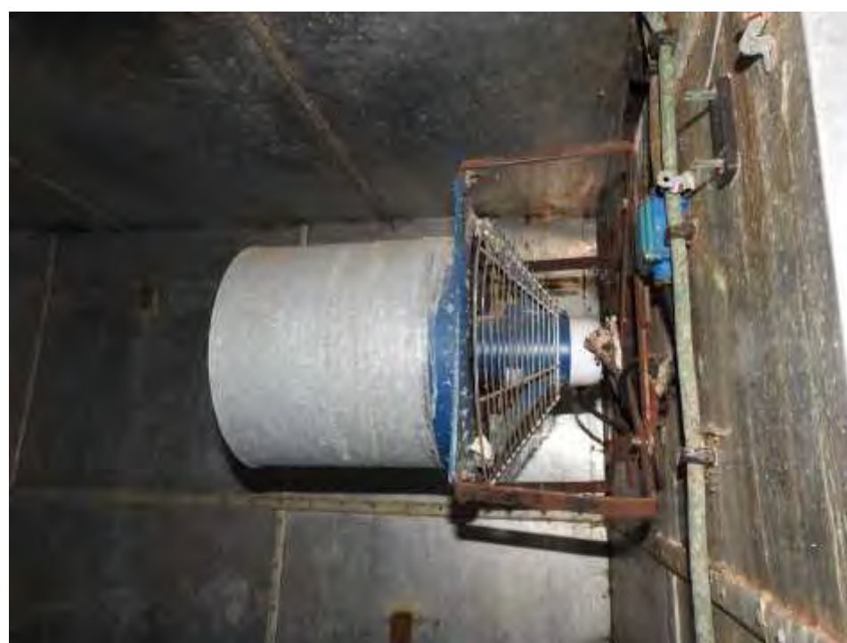
Fotografija postojećeg stanja 164 a, b
