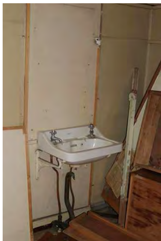
Fotografija postojećeg stanja 59
