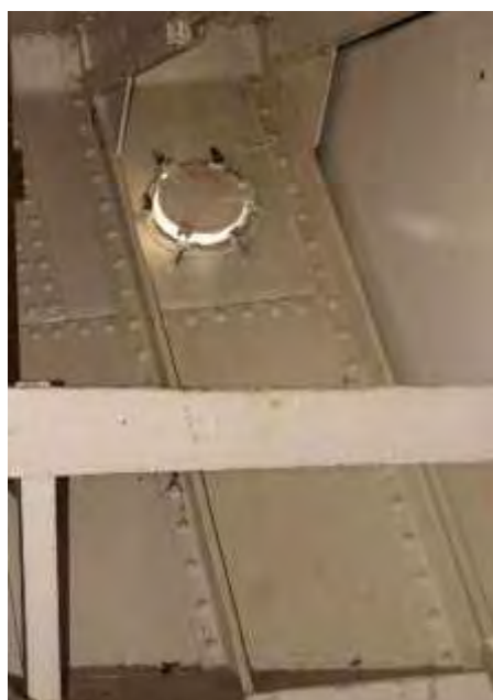
Fotografija postojećeg stanja 98 a, b
