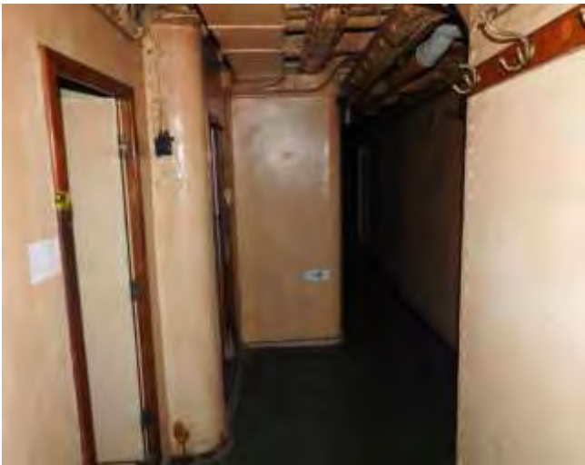
Fotografija postojećeg stanja 53 a, b
