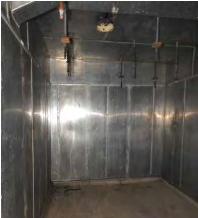
Fotografija postojećeg stanja 135a i b
