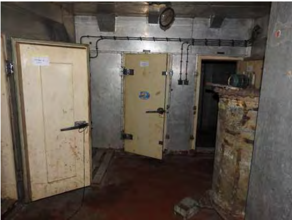
Fotografija postojećeg stanja 163
