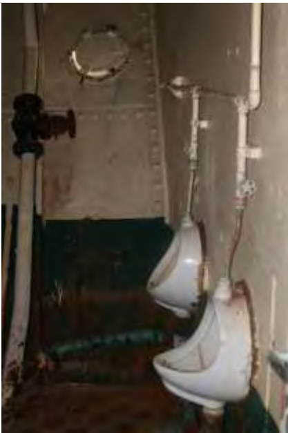
Fotografija postojećeg stanja 96 a, b
