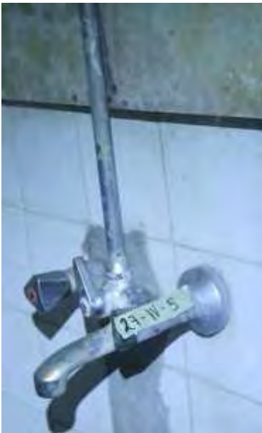
Fotografija postojećeg stanja 76 a, b
