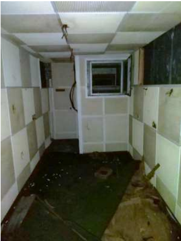
Fotografija postojećeg stanja 10
