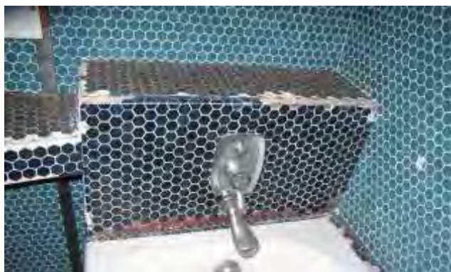
Fotografija postojećeg stanja 29
