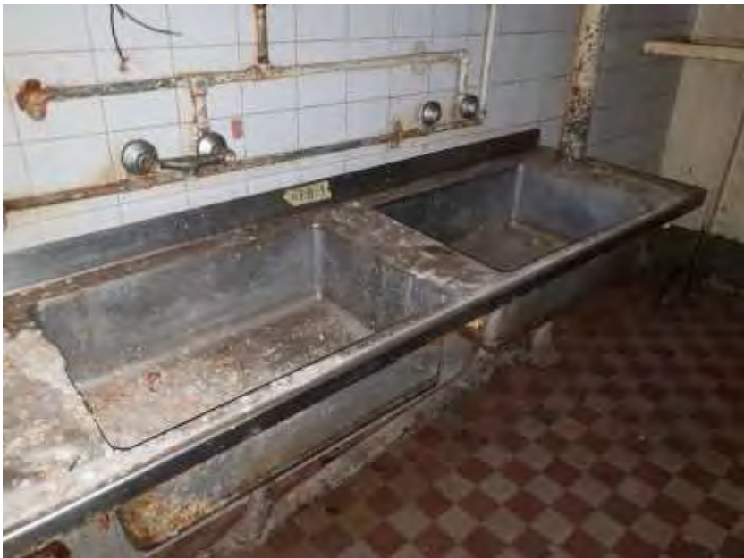
Fotografija postojećeg stanja 148
