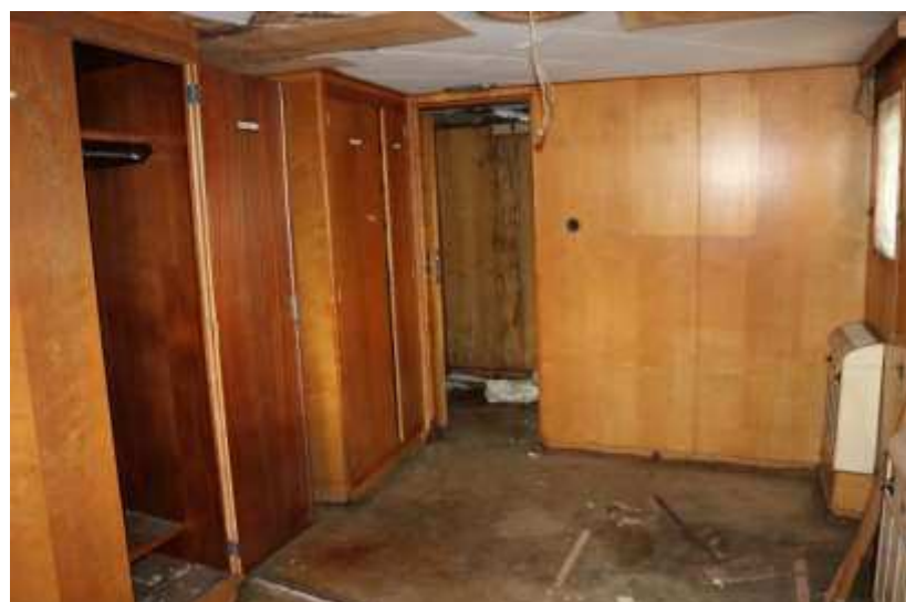
Fotografija postojećeg stanja 18
