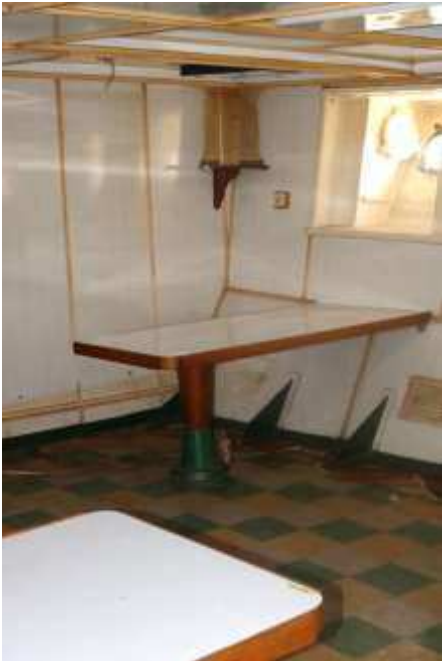
Fotografija postojećeg stanja 89 a, b
