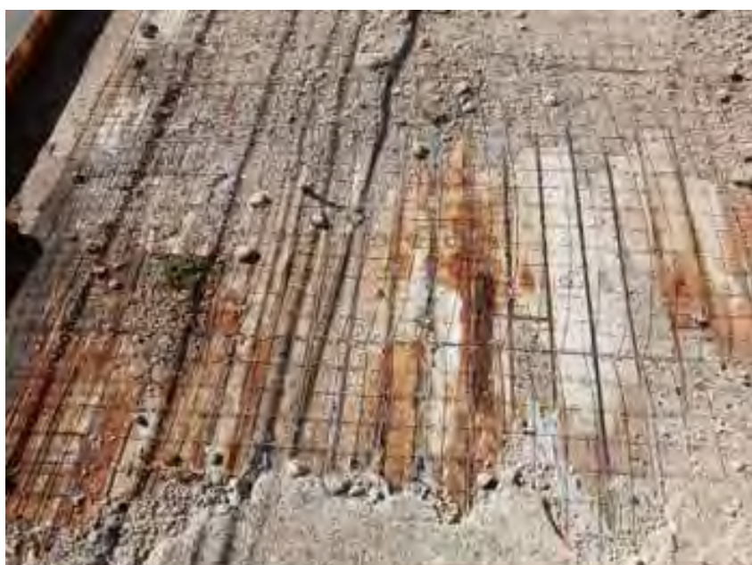
Slika 9, Različite razine degradacije metalnih površina vanjskog dijela nadgrađa, izvor: eLABORO d.o.o.
