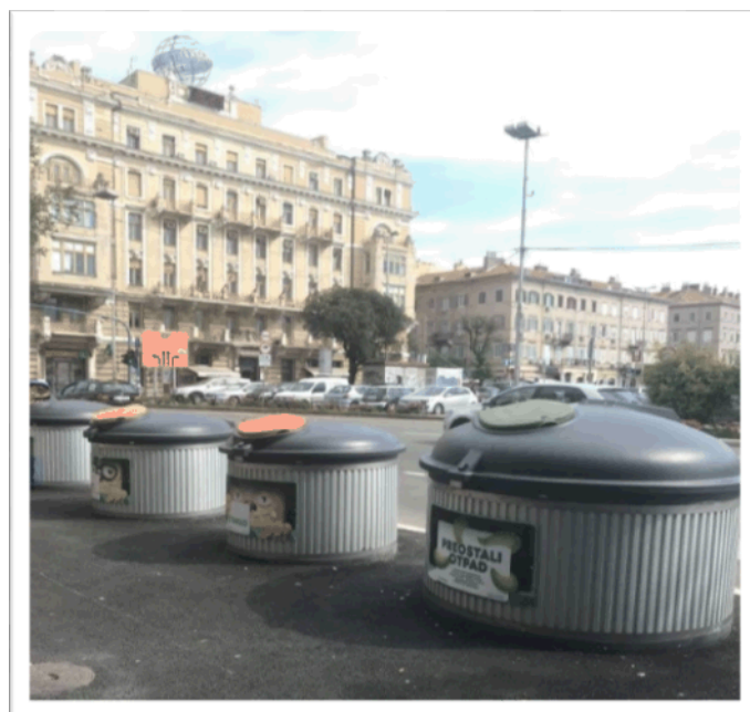
Slika 8. Poluukopani spremnici na lokaciji Riva 4
