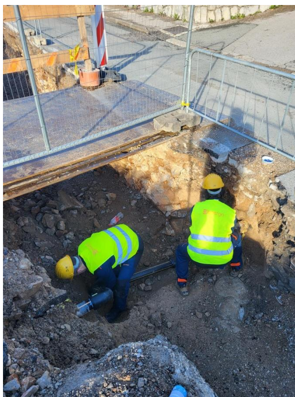
Slika 7: Rekonstrukcija plinovoda na Pehlinu
