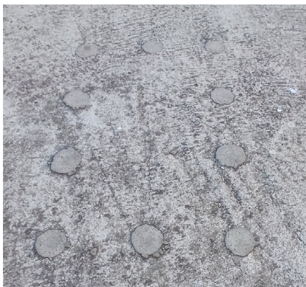
Fotografija 10. Ploča trga: naknadna ojačanja na poziciji stupa G11
