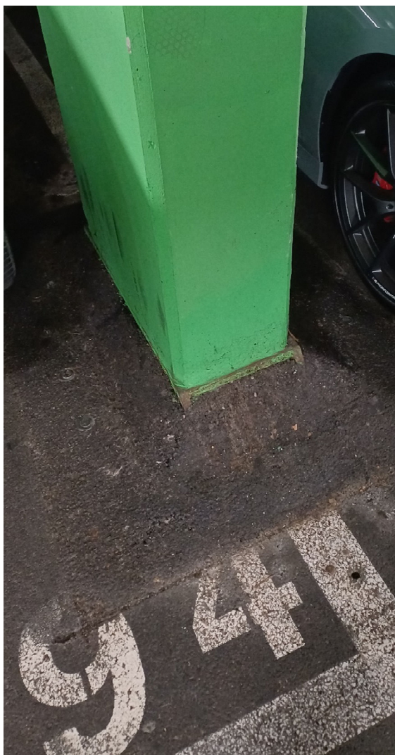
Fotografija 36. Ojačanje temeljne ploče uz stup D5 na razini garaže -2
