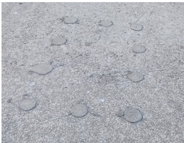
Fotografija 9. Ploča trga: naknadna ojačanja na poziciji stupa G9
