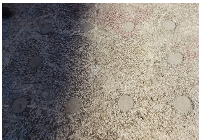
Fotografija 11. Ploča trga: naknadna ojačanja na poziciji stupa H9
