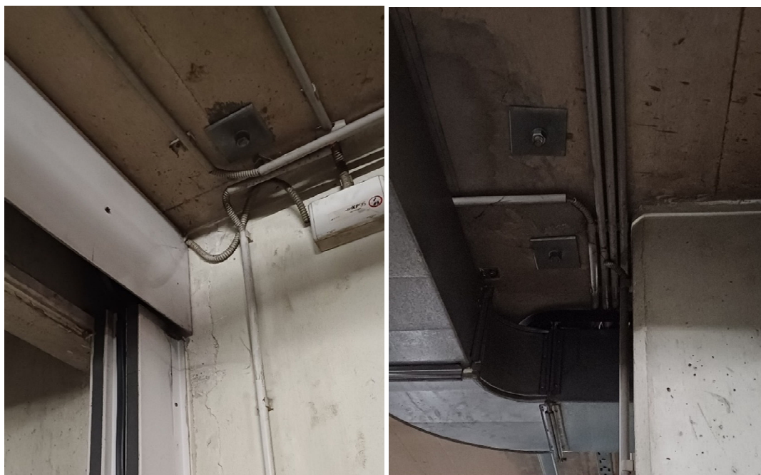
Fotografije 27 i 28. Ojačanje gornje ploče uz stup B6 na razini garaže -2
