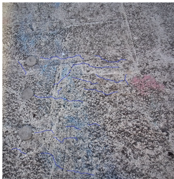
Fotografija 16. Ploča trga: pukotine oko stupa H9 (lijevo: izvorna fotografija, desno: označene radijalne pukotine)
