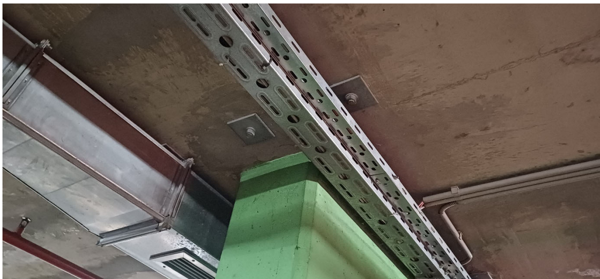
Fotografija 32. Ojačanje gornje ploče uz stup B9 na razini garaže -2 (1)
