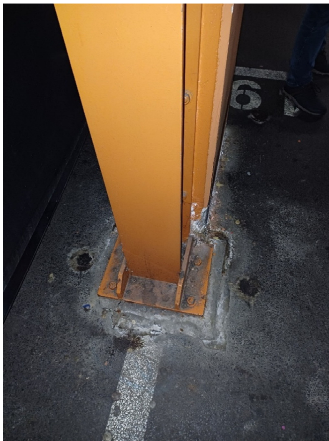
Fotografija 21. Ojačanje uz stup D5 na razini garaže -1 (3)
