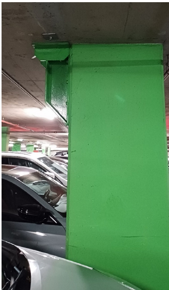
Fotografija 37. Čelično jačanje uz stup D5 na razini garaže -2
