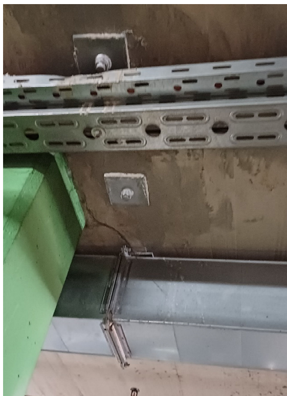
Fotografija 31. Ojačanje gornje ploče uz stup B8 na razini garaže -2 (2)
