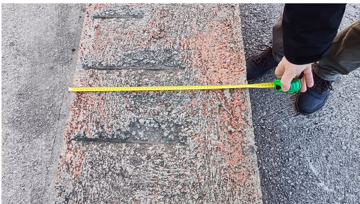
Fotografija 4. Ploča trga: kontragreda za srednjovjekovni zid - utvrđivanje širine; vidljiva armatura na površini
