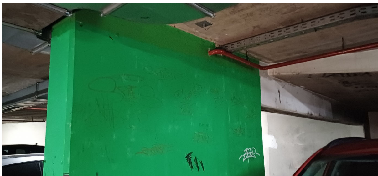
Fotografija 42. Ojačanje povezivanjem dva stupa u osi E2 na razini garaže -2
