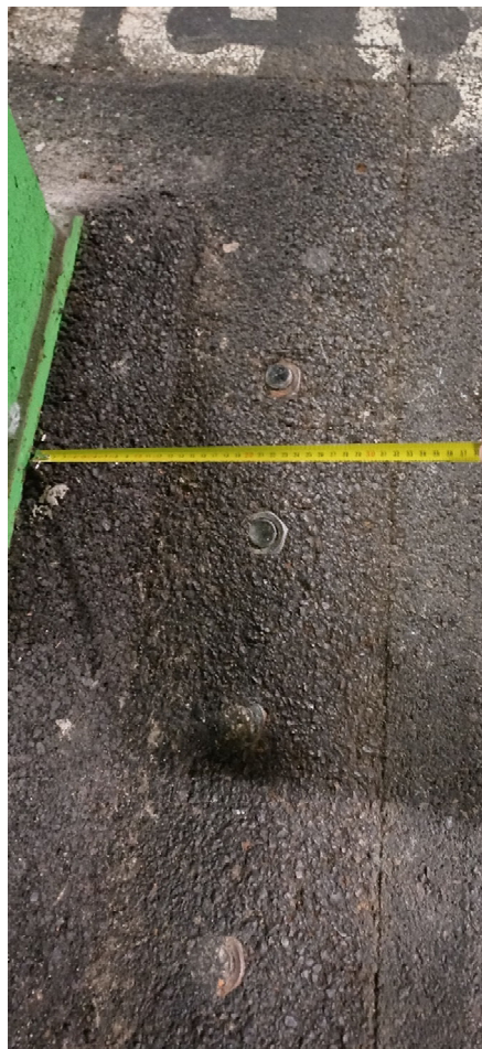
Fotografije 40 i 41. Ojačanje temeljne ploče uz stup E3 na razini garaže -2
