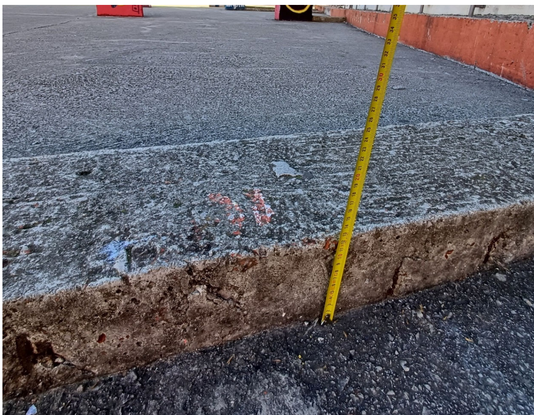
Fotografija 6. Ploča trga: niska kontragreda – određivanje visine
