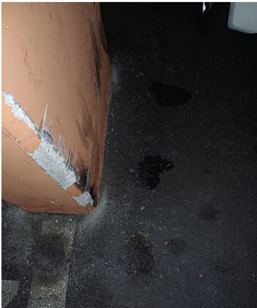
Fotografija 24. Ojačanje donje ploče uz stup F15 na razini garaže -1 (2)
