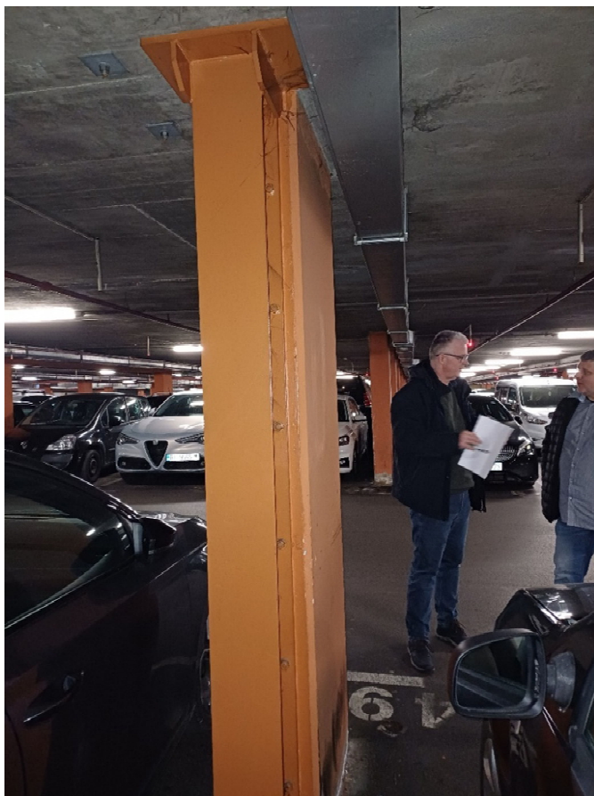
Fotografija 19. Ojačanje uz stup D5 na razini garaže -1 (1)
