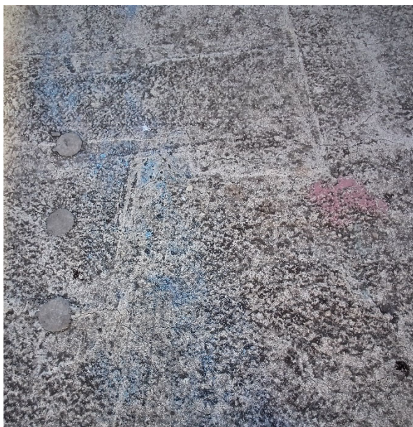
Fotografija 16. Ploča trga: pukotine oko stupa H9 (lijevo: izvorna fotografija, desno: označene radijalne pukotine)
