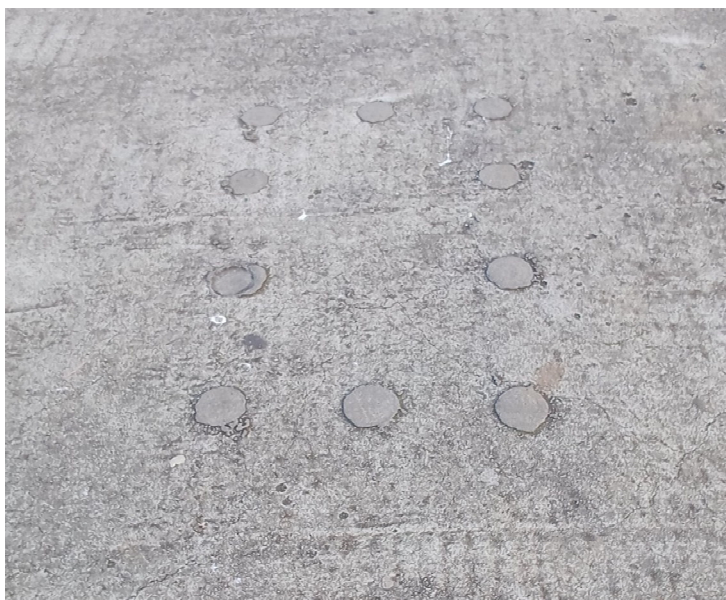
Fotografija 8. Ploča trga: naknadna ojačanja na poziciji stupa H8
