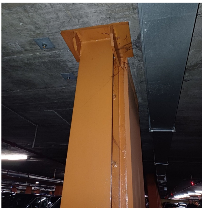
Fotografija 20. Ojačanje uz stup D5 na razini garaže -1 (2)
