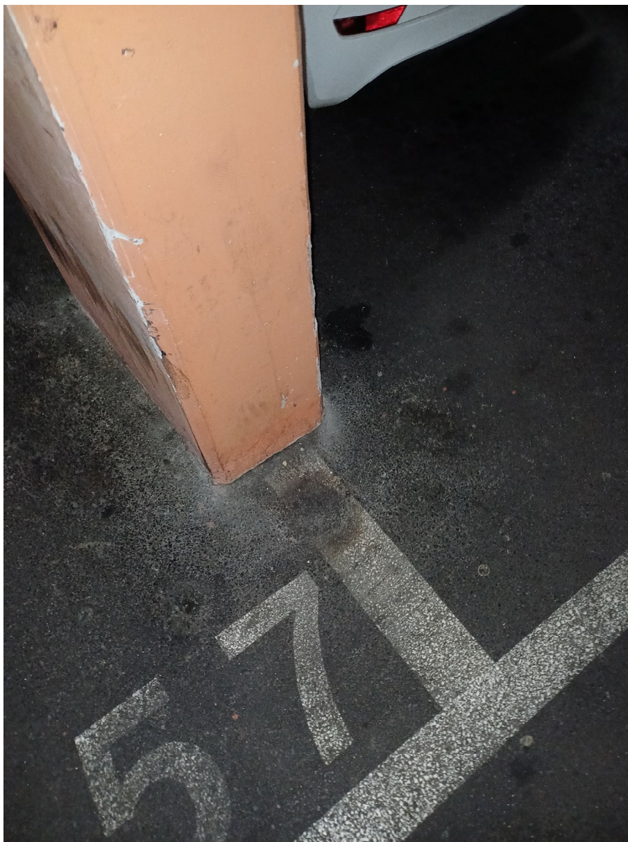
Fotografija 23. Ojačanje donje ploče uz stup F15 na razini garaže -1 (1)
