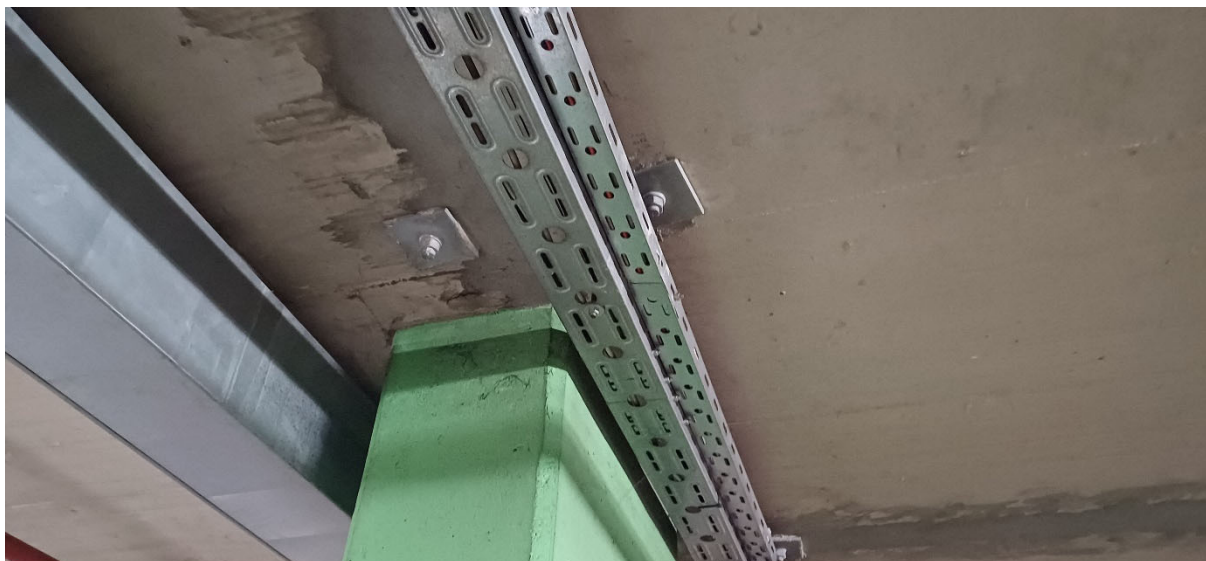
Fotografija 30. Ojačanje gornje ploče uz stup B8 na razini garaže -2 (1)
