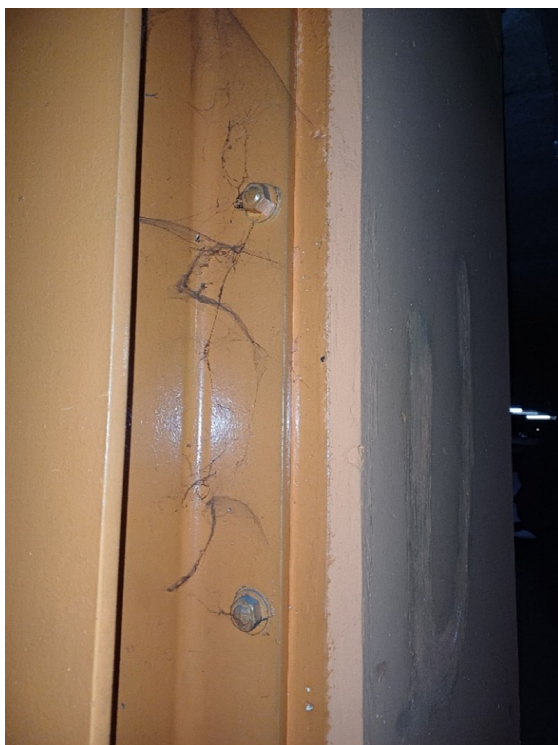
Fotografija 22. Ojačanje uz stup D5 na razini garaže -1 (4)
