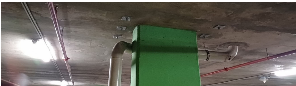
Fotografija 26. Ojačanje gornje ploče uz stup A12 na razini garaže -2 (2)
