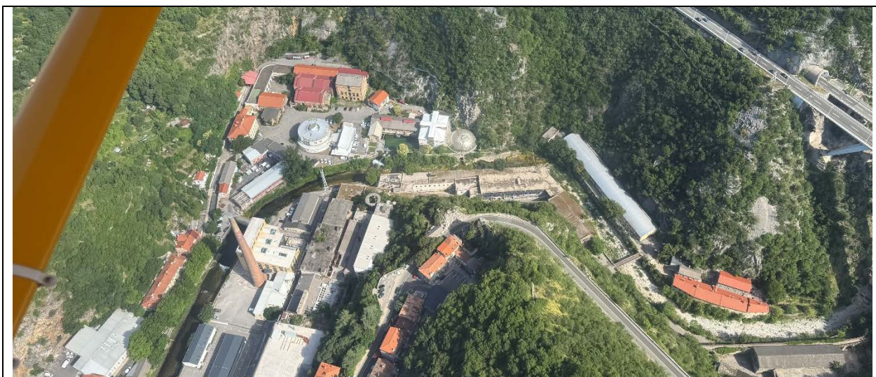
slika 21: upravne zgrade hidroelektrane „Rijeka“
