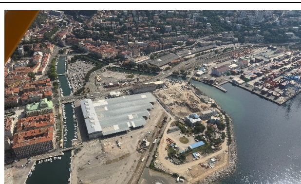
slika 22: gradilište UPOV-a na „Delti”
