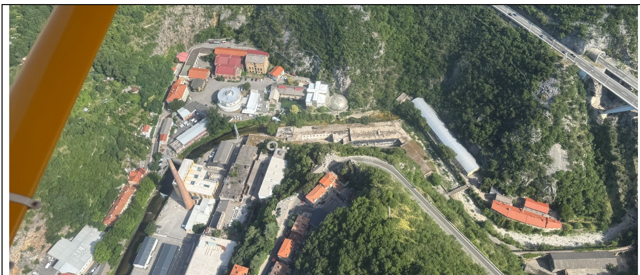
slika 21: upravne zgrade hidroelektrane „Rijeka“
