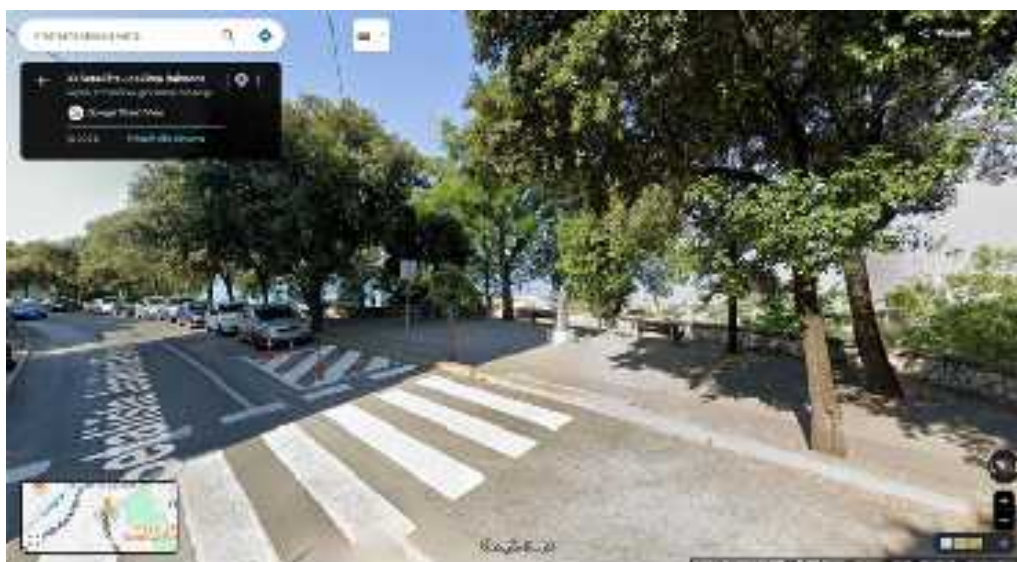
Slika 2. Fotografija predmetne pješačke površine na vrhu Trsatskih stuba – Vidikovac
