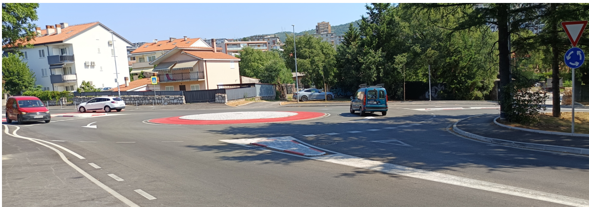
Slika: izvedena rekonstrukcija raskrižja na Radničkoj ulici, rotor na Podvežici
